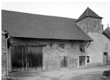
Bâtiment des dépendances et colombier. Phot. Michel Rosso IVR26_19867100185V
