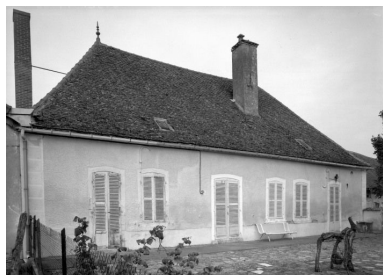
Bâtiment d'habitation, façade sur jardin. Phot. Michel Rosso IVR26_19867100192V
