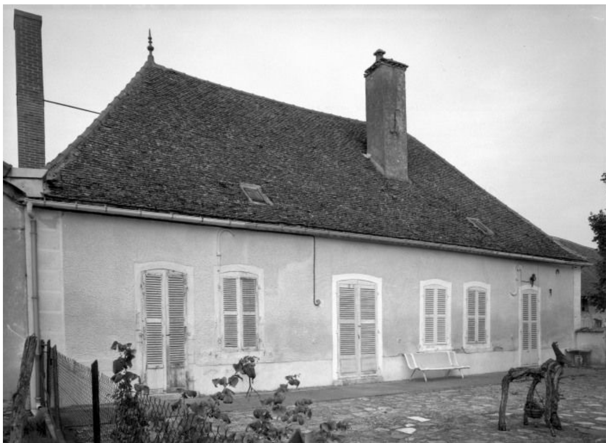
Bâtiment d'habitation, façade sur jardin.
