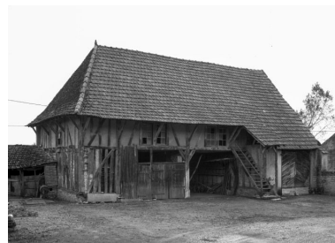
Bâtiment abritant les remises et le séchoir. Phot. Michel Rosso IVR26_19867100186V
