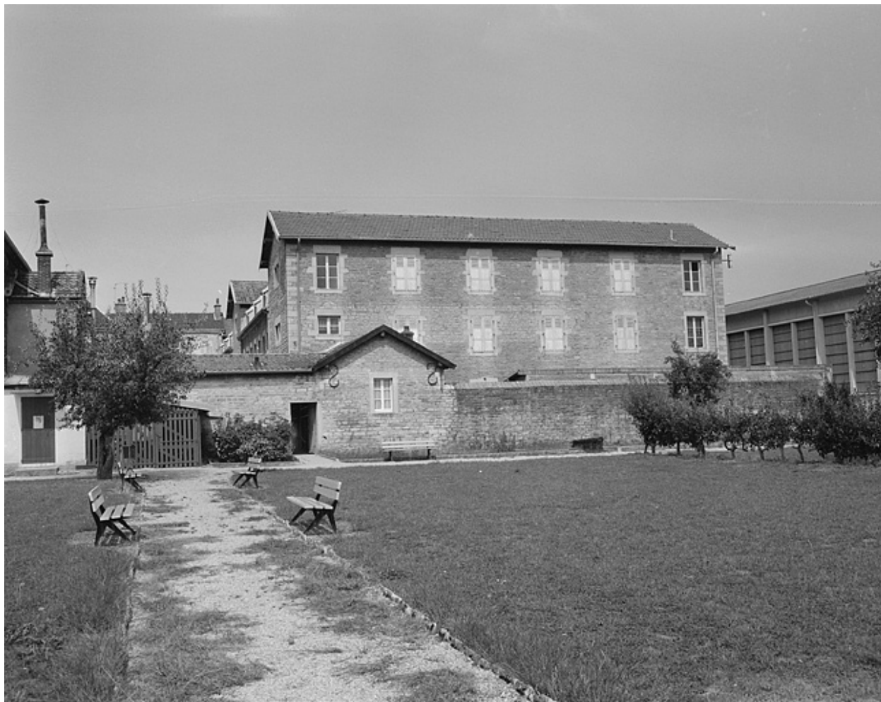
Façade latérale d'un des pavillons en1983.
