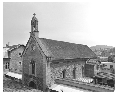
Chapelle, vue des parties hautes en 1983. Phot. Yves Sancey IVR43_19833900139X
