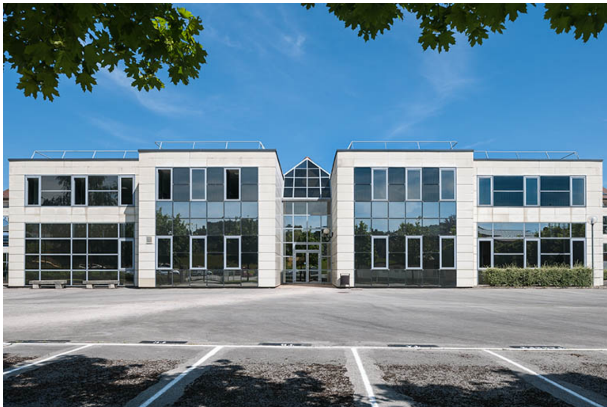
Façades extension Sud : externat
