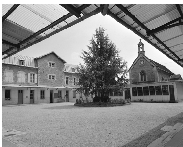
Cour intérieure et chapelle en 1983. Phot. Yves Sancey IVR43_19833900138X
