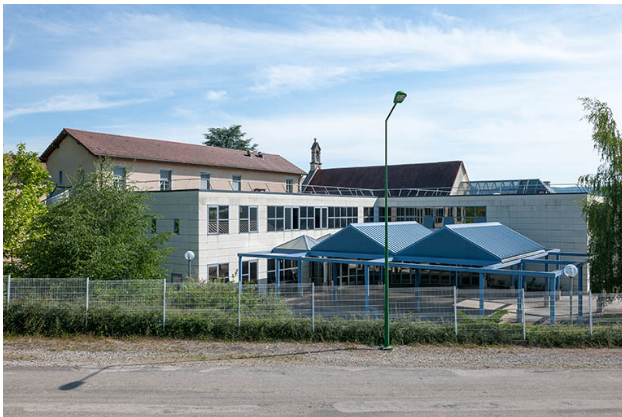
Extensions Sud-ouest : préau et bâtiment à usage de cafétéria
