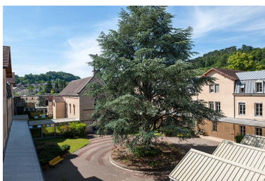
Vue de la cour intérieure
