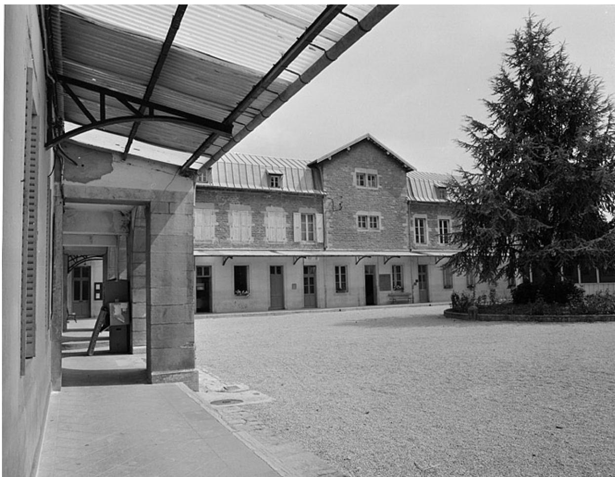
Cour intérieure, vue depuis le pavillon d'entrée en 1983.
