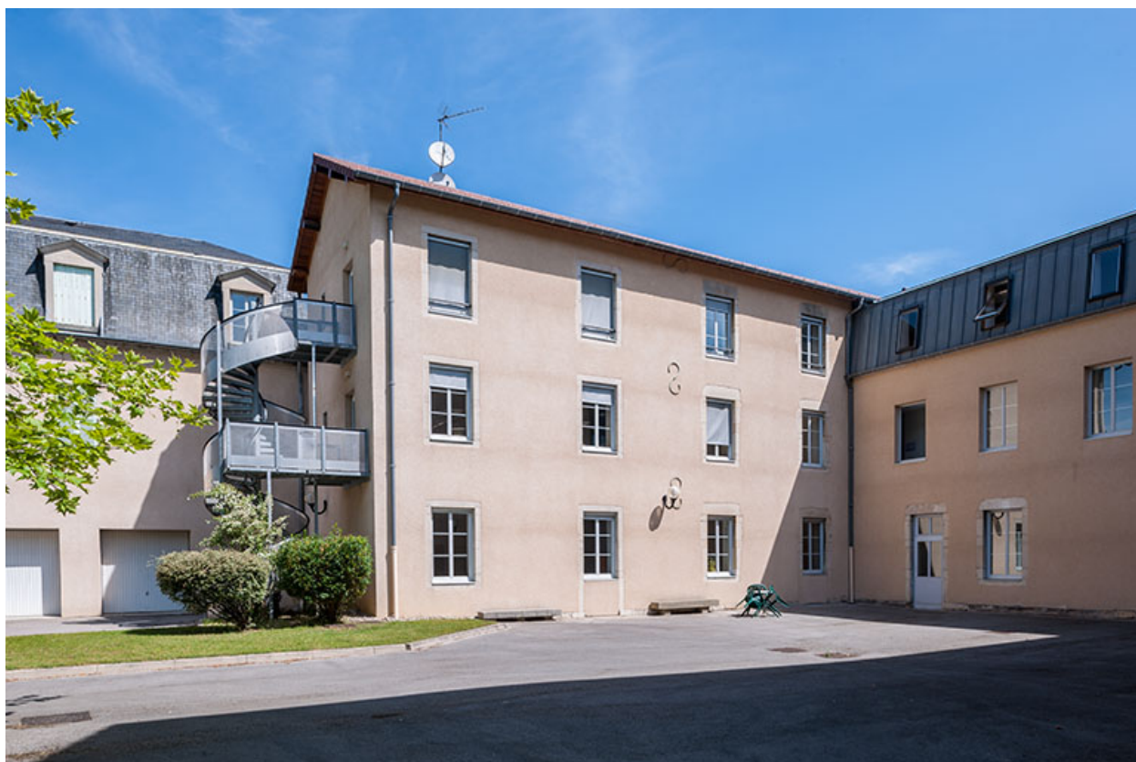
Façades postérieures des bâtiments administration.
