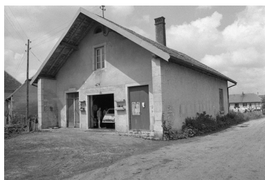
Vue de trois quarts droit en 1975. Phot. Gilbert Poinot IVR43_19752500822Z
