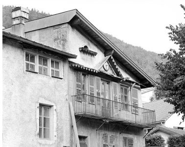
Etage du corps de bâtiment nord. Phot. Yves Sancey IVR43_20033900443X
