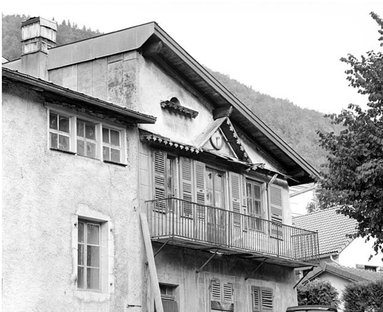
Etage du corps de bâtiment nord.
