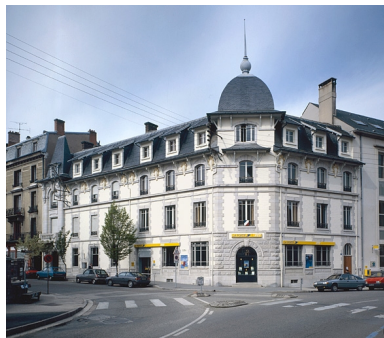
Façade antérieure. Phot. Yves Sancey IVR43_19883900096VA
