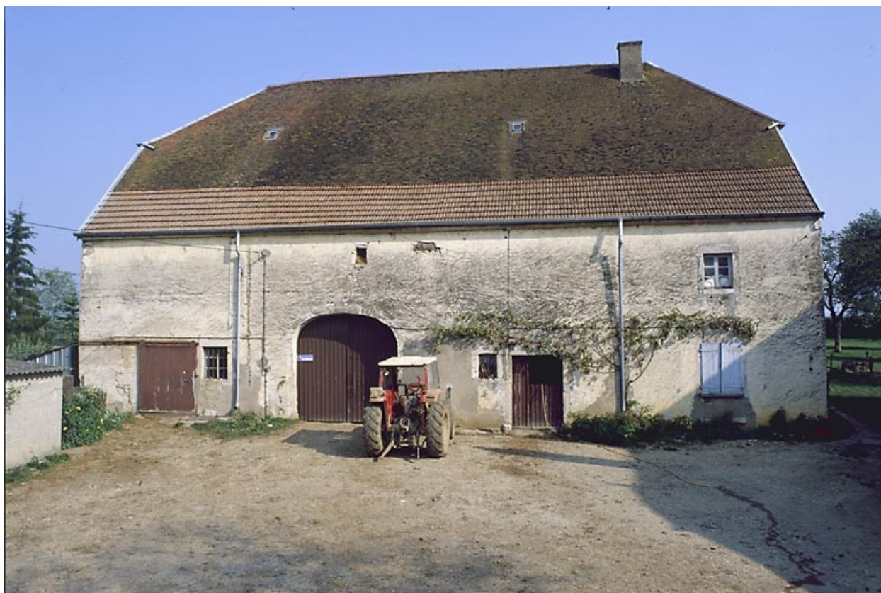
Façade sur cour.
