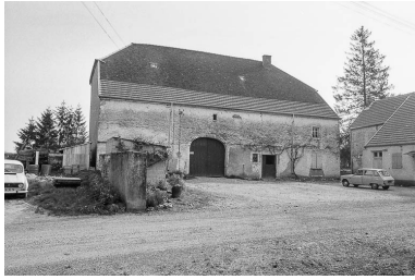
Vue d'ensemble. Phot. Bernard Lardière IVR43_19817000234Z
