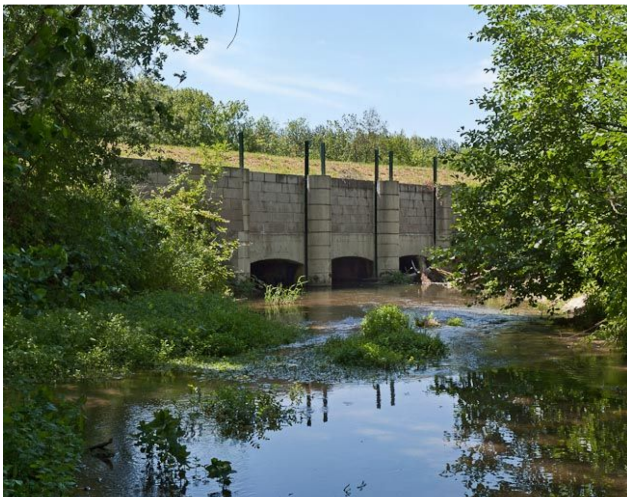
Vue de l'aqueduc.
