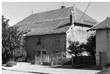
Ferme située 1 route de la Barèche. Phot. Yves Sancey IVR43_19802501073X
