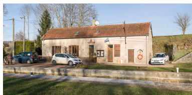
La maison éclusière vue de 3/4. Phot. Pierre-Marie Barbe-Richaud IVR26_20132101034NUC4AQ
