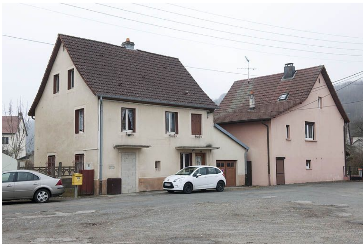
Maisons individuelles rue de la Poste.
