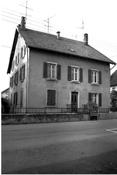
Vue d'ensemble. Phot. Bernard Lardière IVR43_19832500217Z
