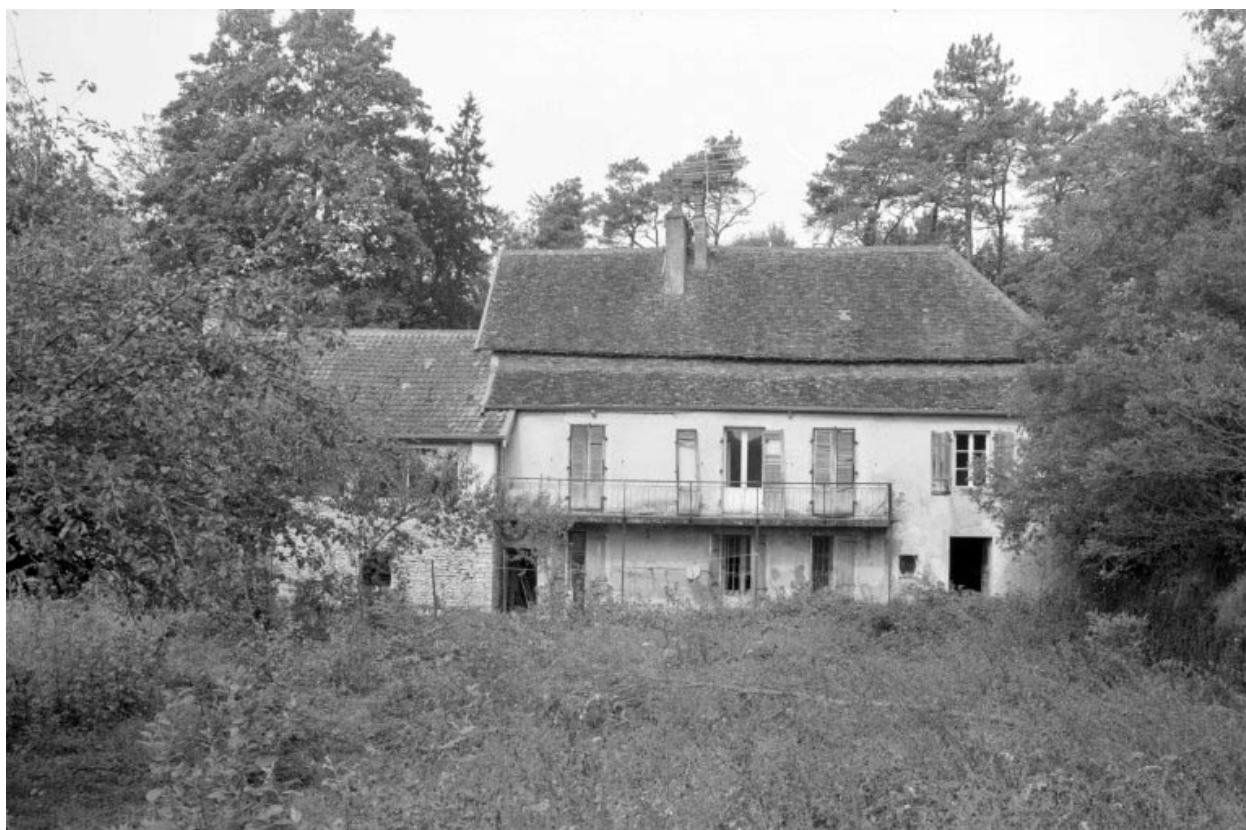
Façade latérale droite du logement patronal.
