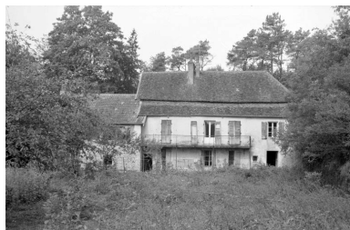
Façade latérale droite du logement patronal.
