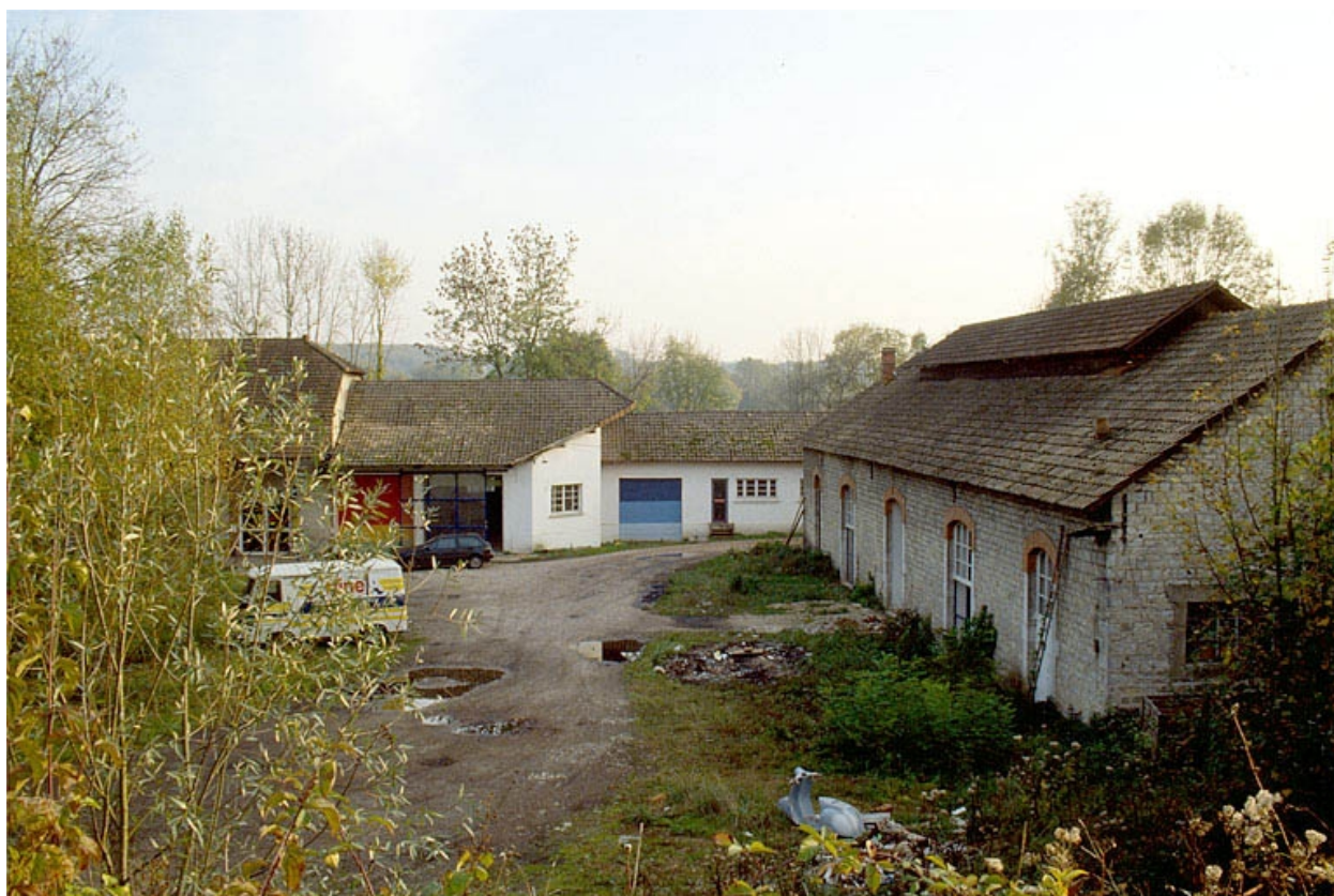
Magasin industriel (E) et atelier de réparation.
