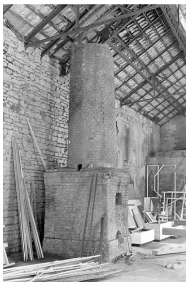
Atelier de réparation, intérieur : base de cheminée.
