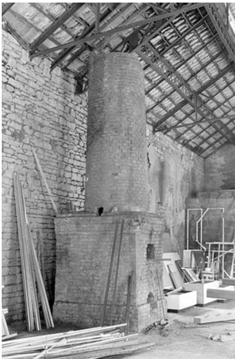
Atelier de réparation, intérieur : base de cheminée.
