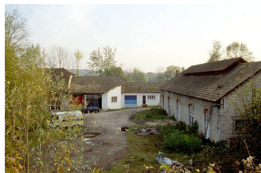
Magasin industriel (E) et atelier de réparation. Phot. Laurent Poupard IVR43_19883900603ZA
