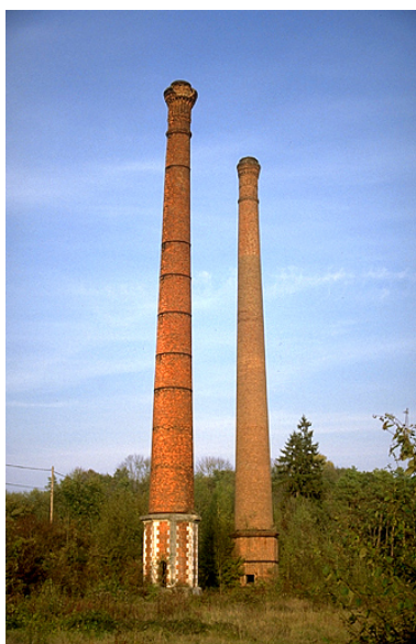
Cheminées d'usine, depuis le sud-ouest.
