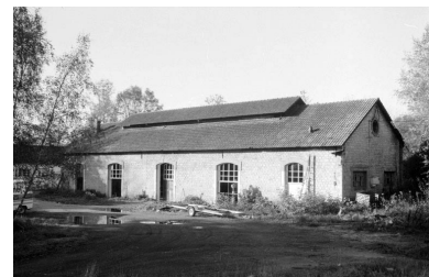
Atelier de réparation, de trois quarts droit. Phot. Laurent Poupard IVR43_19883900604Z
