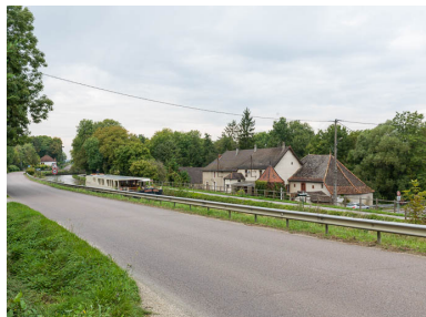
Vue d'ensemble du domaine, du canal et du chemin de halage. Phot. Pierre-Marie Barbe-Richaud IVR26_20177100408NUC2A
