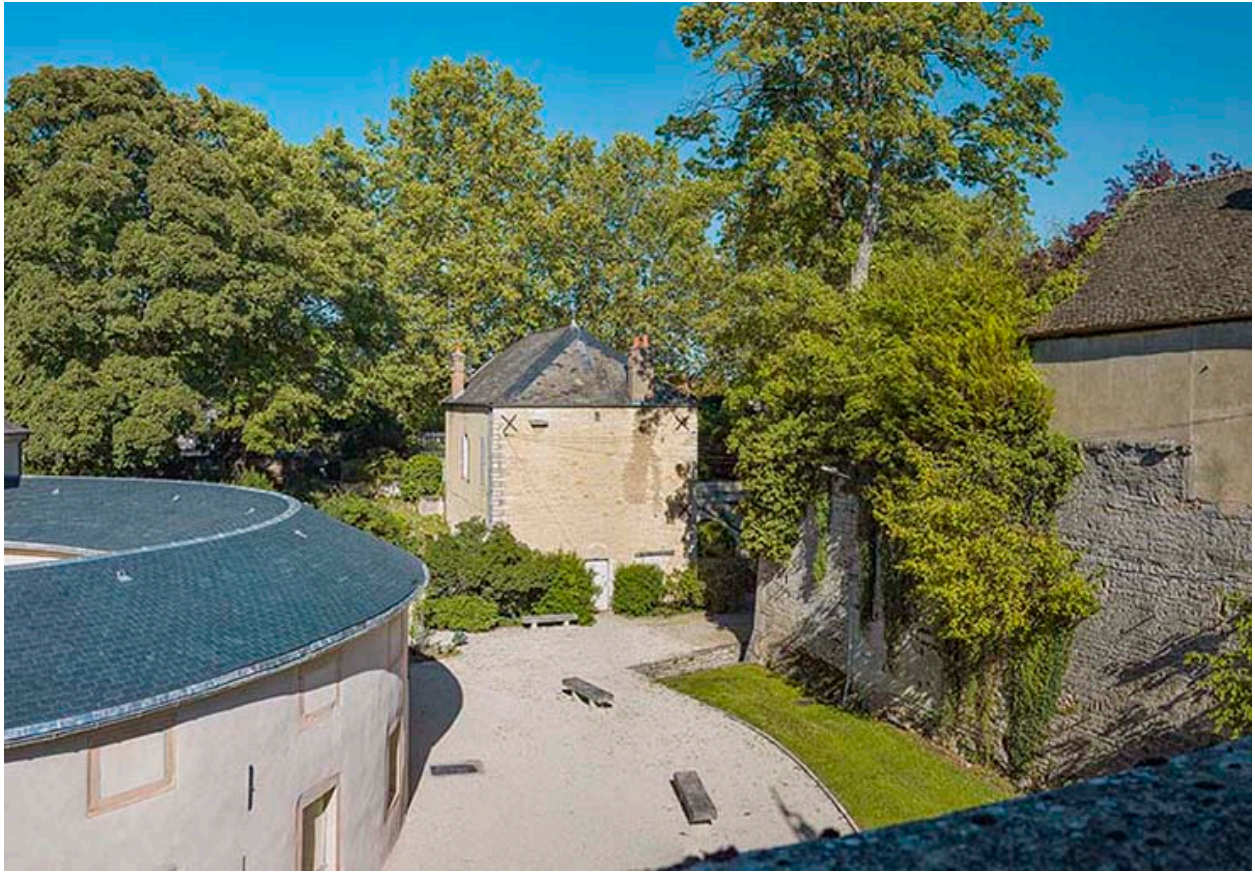
Flanc ouest du bastion.
