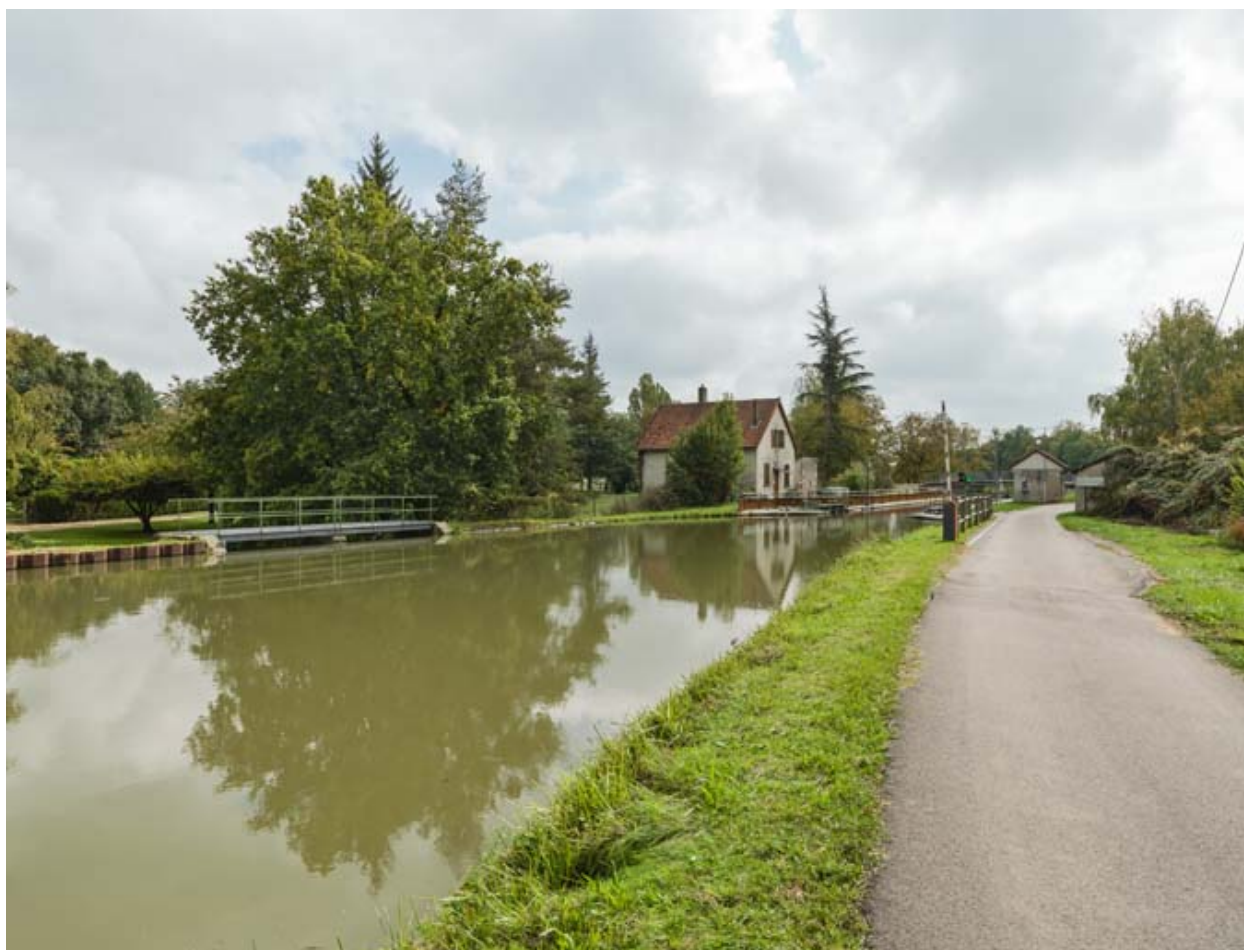
Vue d'ensemble du site d'écluse.
