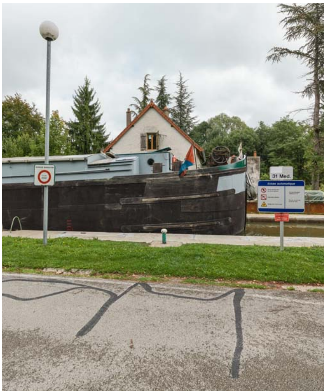
Vue rapprochée de l'écluse.
