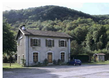
Bâtiment des voyageurs : façade antérieure, de trois quarts gauche. Phot. Yves Sancey IVR43_20043900495ZA
