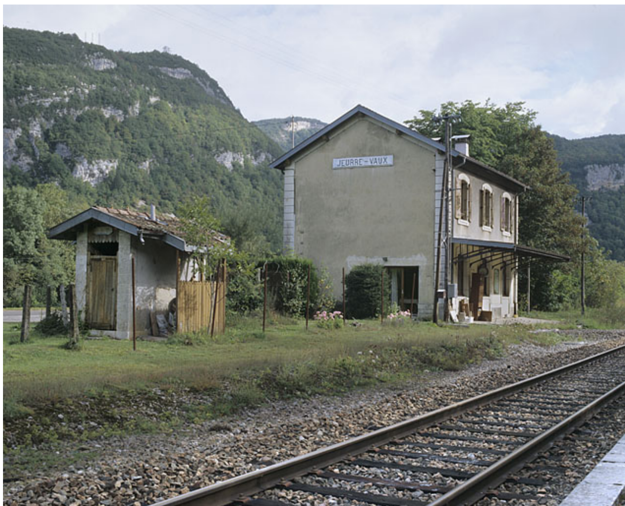
Bâtiment des voyageurs et latrines, depuis la voie côté La Cluse (sud-ouest).
