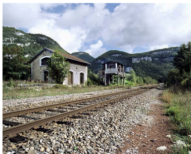
Entrepôt et silo à sciure, depuis la voie côté La Cluse (sud-ouest). Phot. Yves Sancey IVR43_20043900505XA
