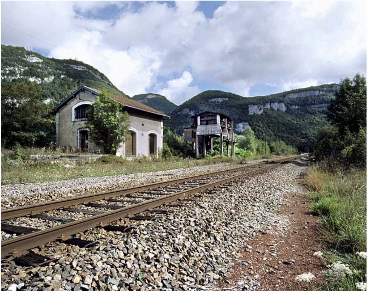
Entrepôt et silo à sciure, depuis la voie côté La Cluse (sud-ouest).
