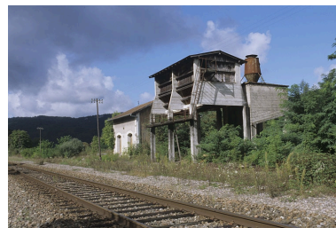
Entrepôt et silo à sciure, depuis la voie côté Andelot- en-Montagne (nord-est). Phot. Yves Sancey IVR43_20043900507ZA
