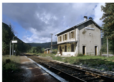
Bâtiment des voyageurs : façade postérieure, de trois quarts droite. Phot. Yves Sancey IVR43_20043900503XA
