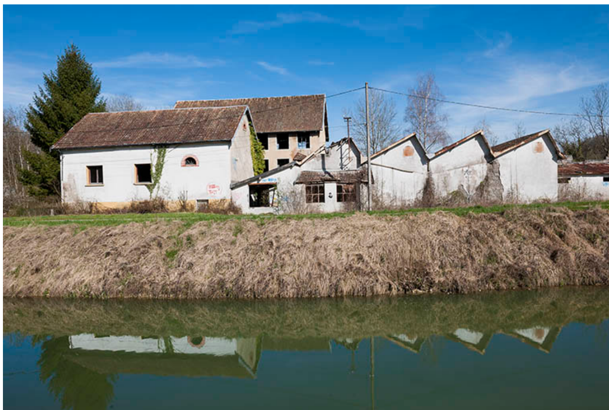
Façades sud de l'usine.
