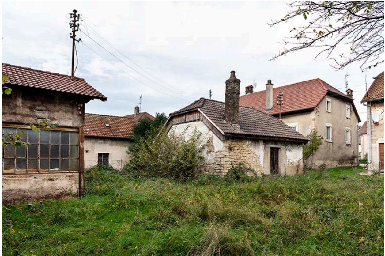
Forge : façades postérieure et latérale gauche.
