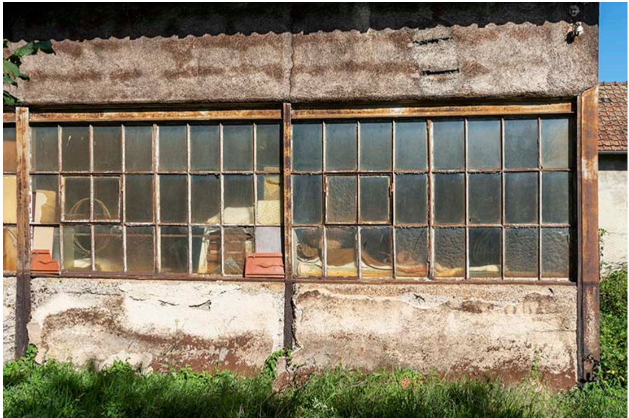
Polissage : baies d'atelier.
