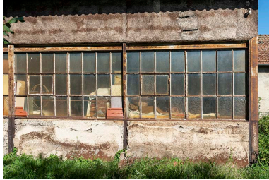
Polissage : baies d'atelier.
