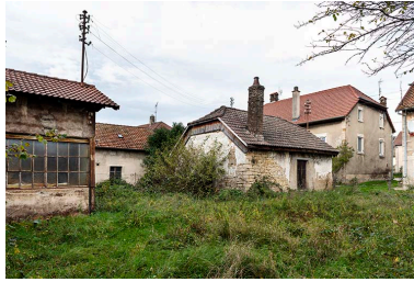
Forge : façades postérieure et latérale gauche.
