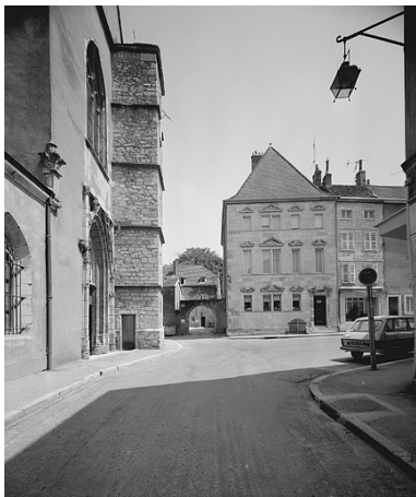
Vue d'ensemble depuis la ruelle de l'Eglise. Phot. Yves Sancey IVR43_19897000393V
