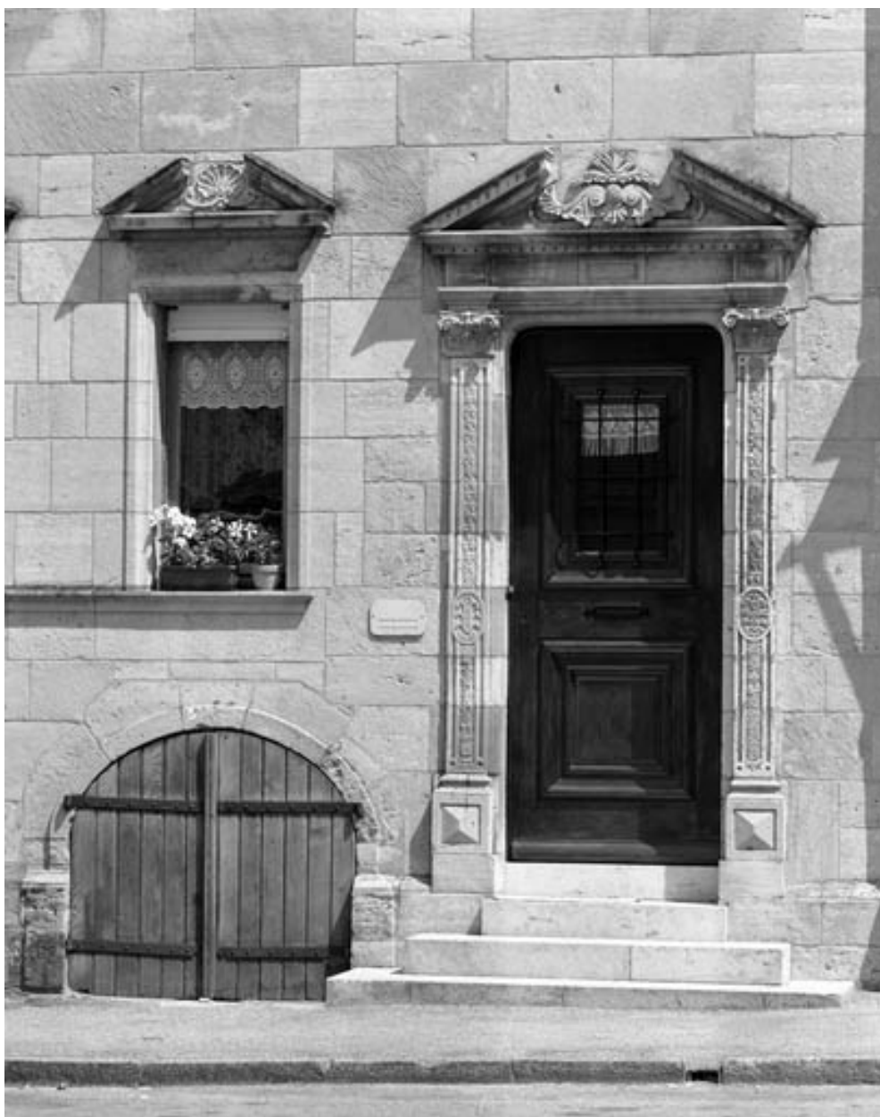
Façade antérieure : détail porte d'entrée sur rue.
