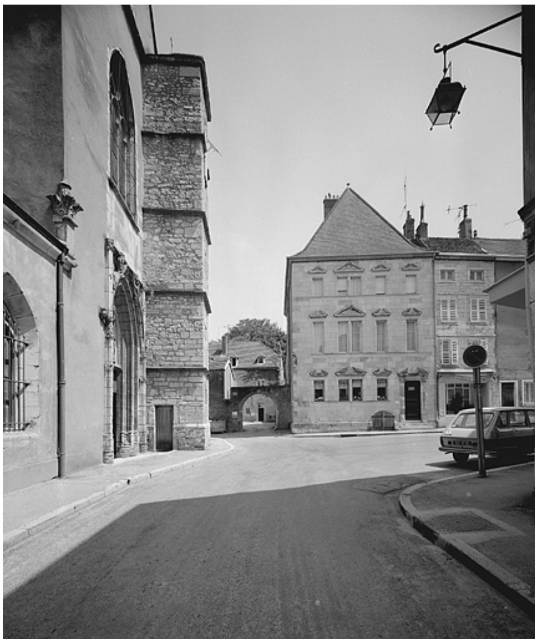
Vue d'ensemble depuis la ruelle de l'Eglise.
