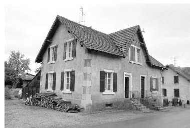
Maison à deux logements rue Bellevue en 1980. Phot. Bernard Lardière IVR43_19809000065Z
