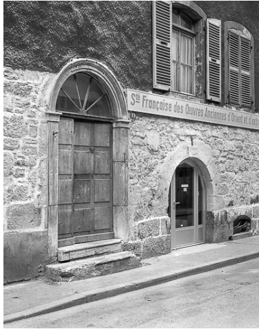
Détail : porte d'entrée. Phot. Yves Sancey IVR43_19802500274X
