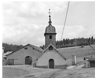
Façade postérieure. Phot. Yves Sancey IVR43_19782500478X
