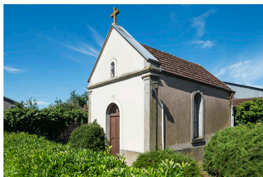
Vue générale de la chapelle.
