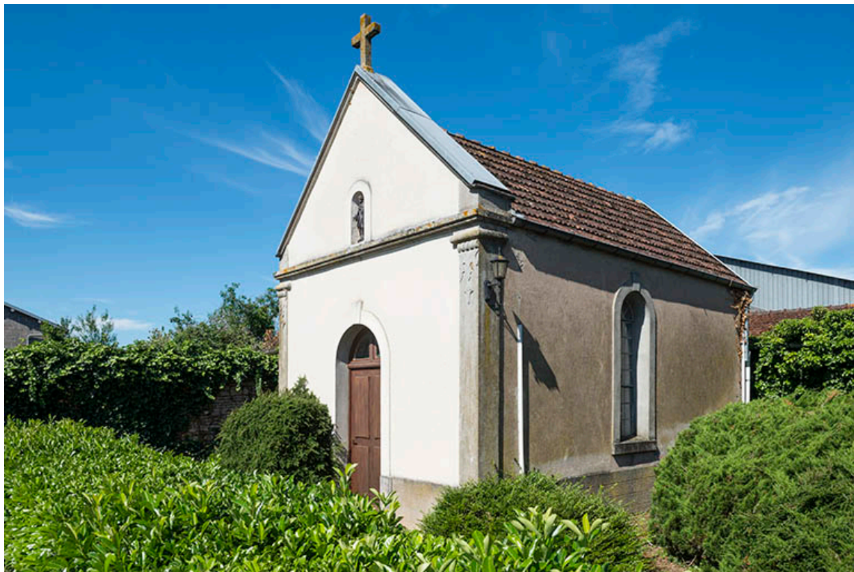
Vue générale de la chapelle.
