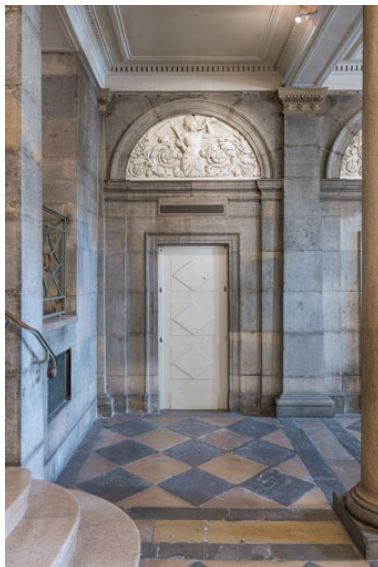
Mur latéral droite (côté cour) : porte de gauche. Phot. Pierre-Marie Barbe-Richaud IVR26_20222100550NUC4A
