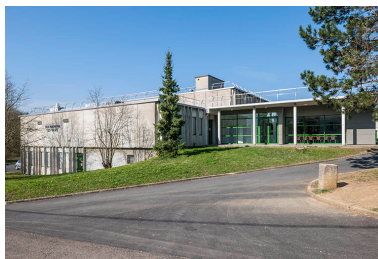
Bâtiment restauration : façade latérale. Phot. Jérôme Mongreville IVR43_20143900158NUC4A
