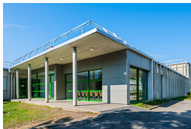
Bâtiment restauration. Phot. Jérôme Mongreville IVR43_20143900159NUC4A
