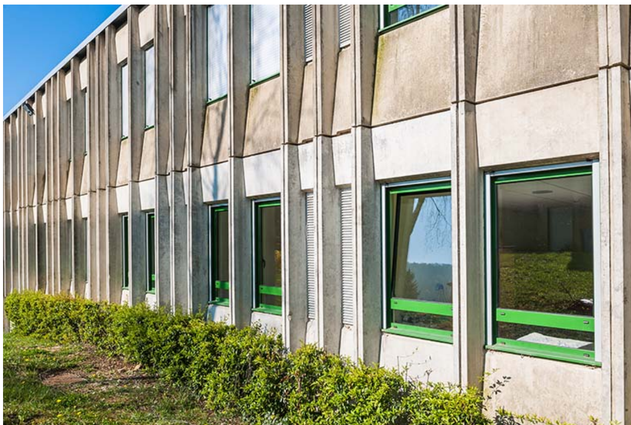
Façades préfabriquées : détail.
