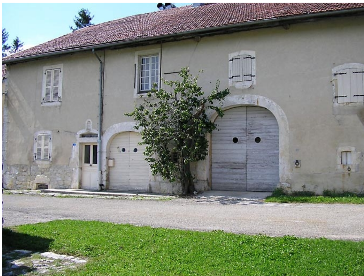
Vue de la façade antérieure.
