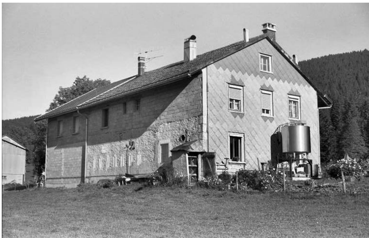
Façades postérieure et latérale gauche.
