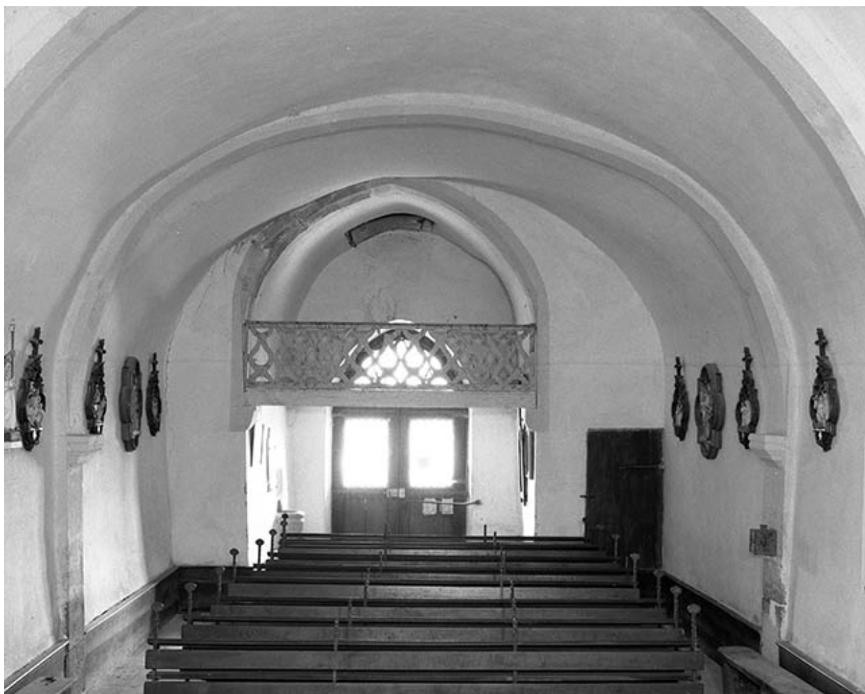
Nef vue depuis le chœur.
