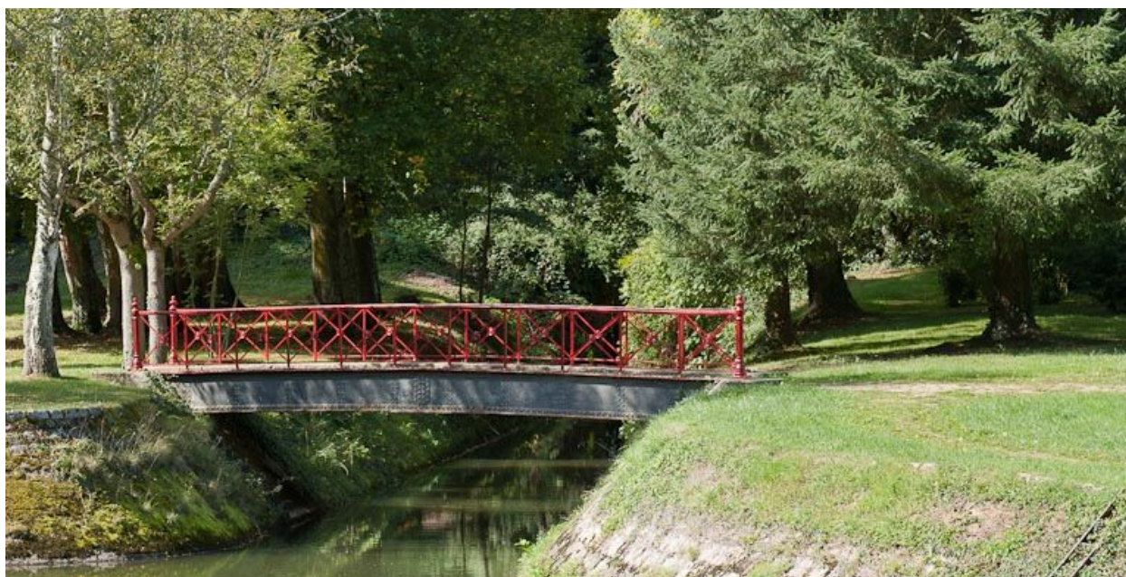
Vue d'un pont sur rigole.
