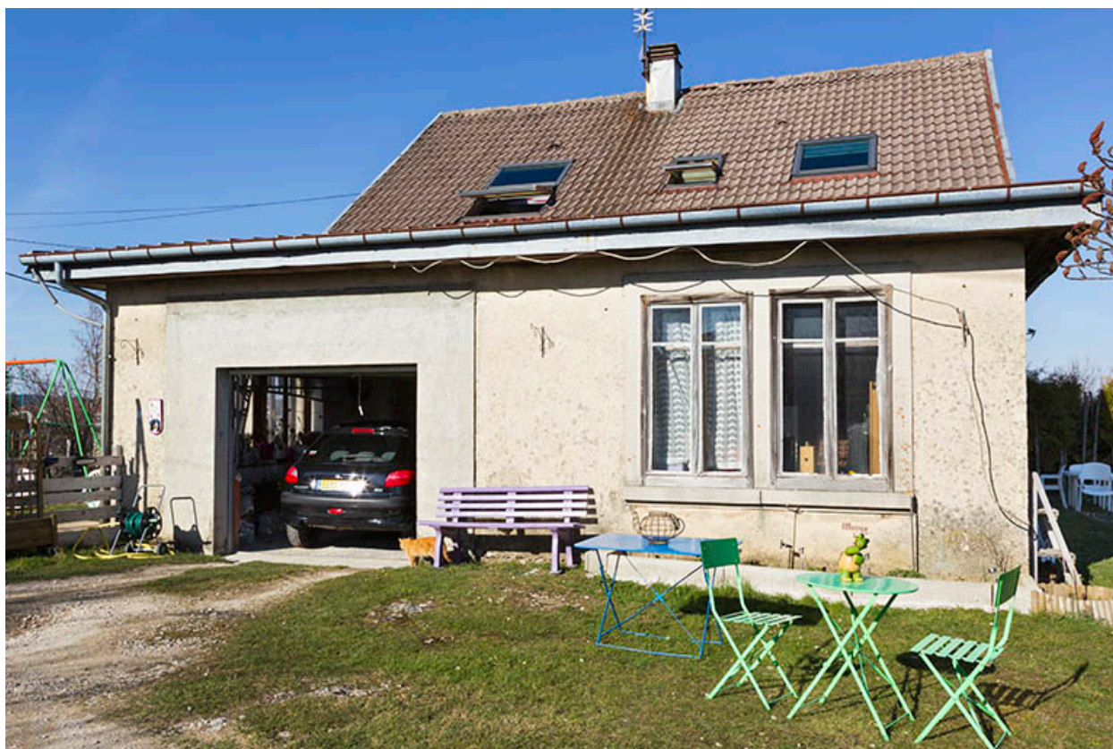
Atelier de fabrication : façade latérale gauche.
