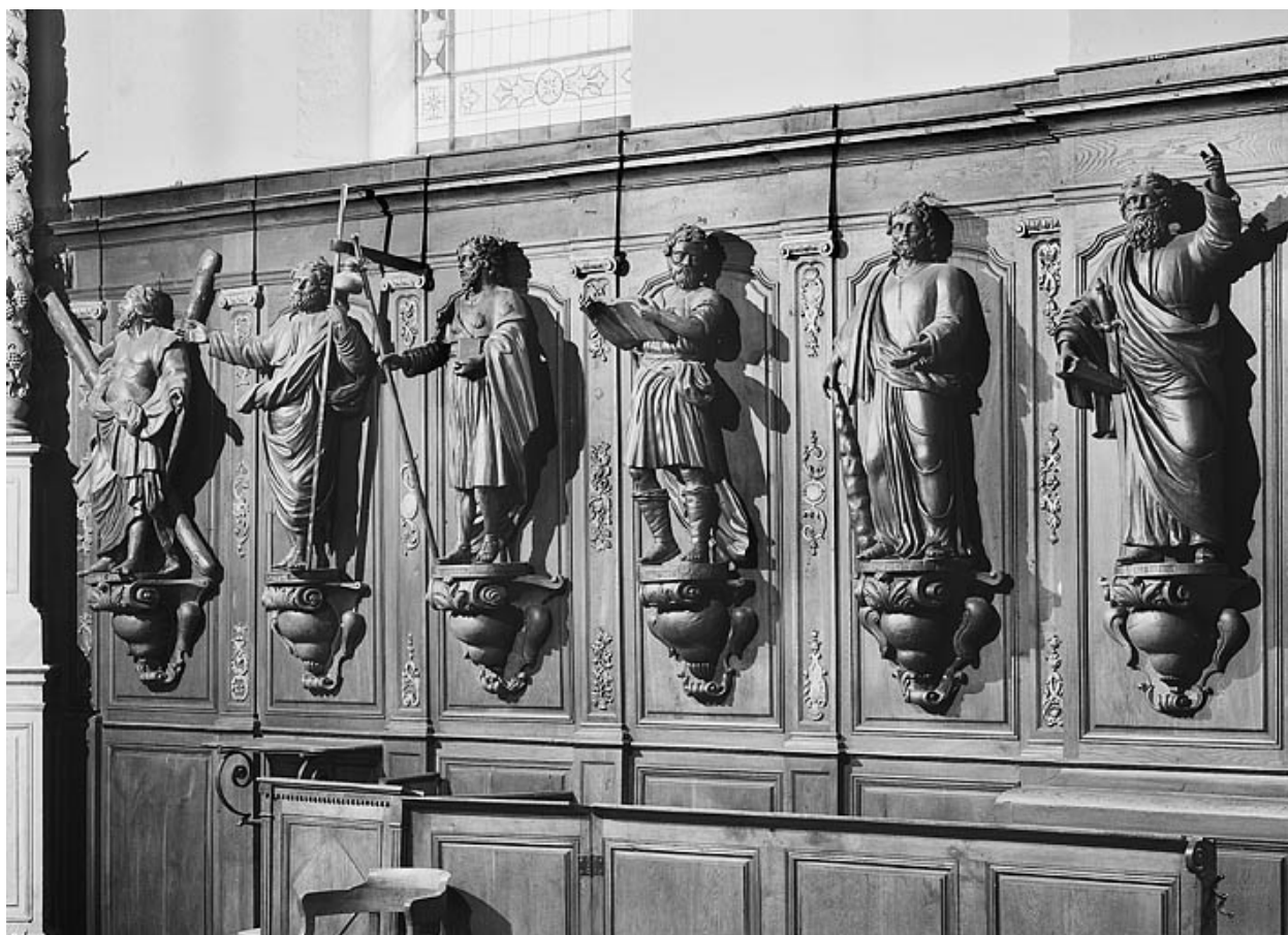
Lambris de revêtement et 12 statues des apôtres : vue du côté sud.
