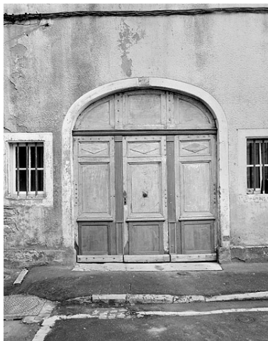
Portail de la maison édifiée à l'emplacement de l'ancienne grange. Phot. Jérôme Mongreville IVR43_19872500975X
