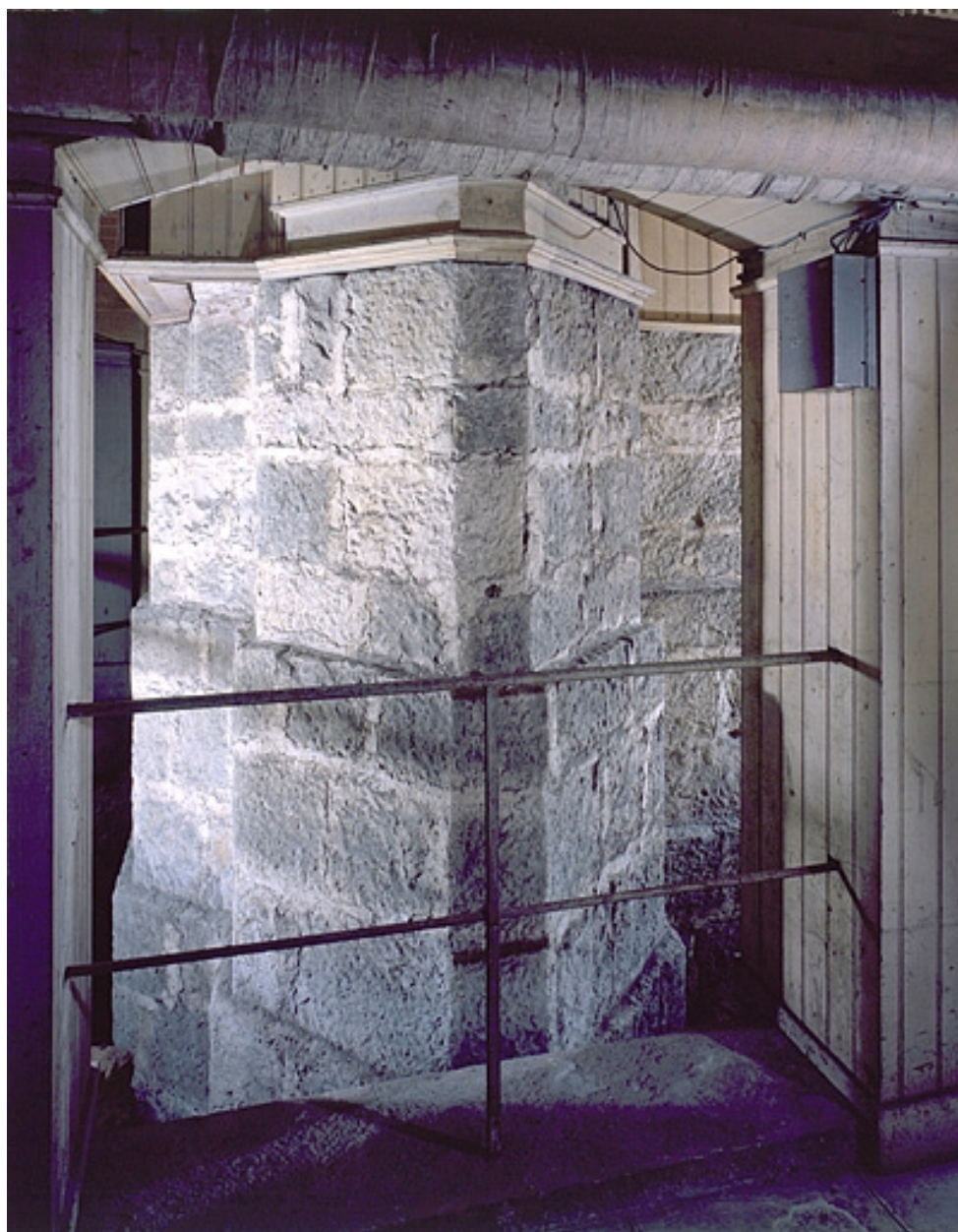
Sous-sol : pilier de la lunette méridienne et de sa pendule.
