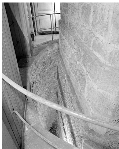
Sous-sol : puits du pilier de la lunette méridienne. Phot. Jérôme Mongreville IVR43_20022500998X
