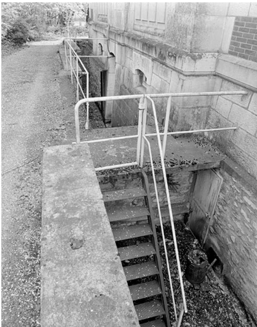
Fossé et escaliers d'accès au sous-sol.
