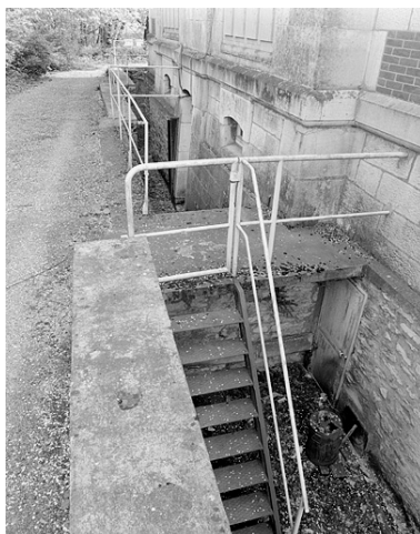
Fossé et escaliers d'accès au sous-sol. Phot. Jérôme Mongreville IVR43_20022501130X
