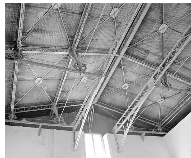
Charpente métallique de la toiture. Phot. Jérôme Mongreville IVR43_20042500034X
