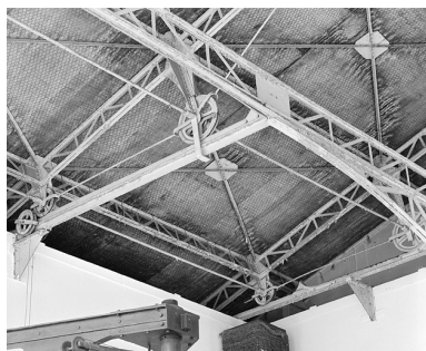
Système d'ouverture de la toiture : poulie, roues métalliques et rails. Phot. Jérôme Mongreville IVR43_20042500035X
