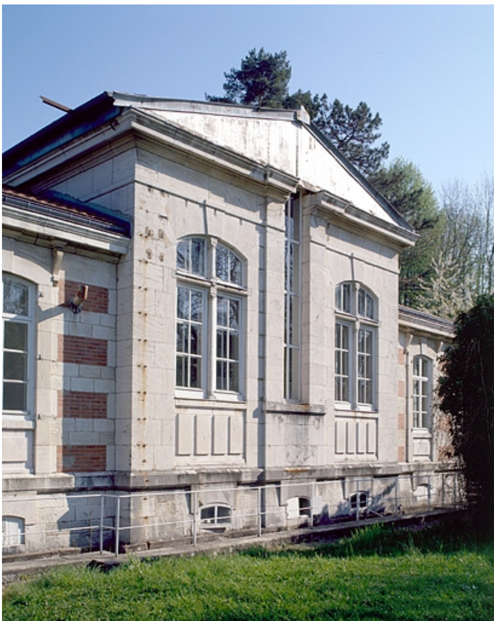
Façade sud, de trois quarts gauche.
