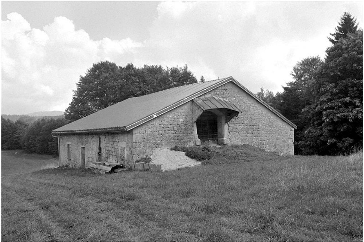
Face sud-ouest et façade postérieure.
