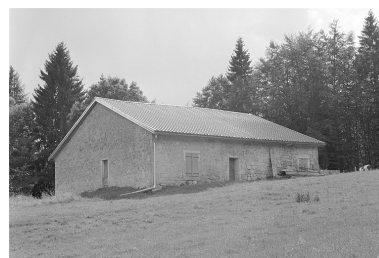
Face nord-est et façade postérieure. Phot. Jérôme Mongreville IVR43_19963901278X
