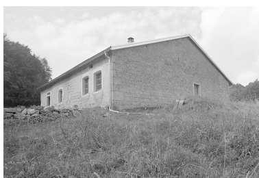
Façade antérieure et face nord-est. Phot. Jérôme Mongreville IVR43_19963901277X
