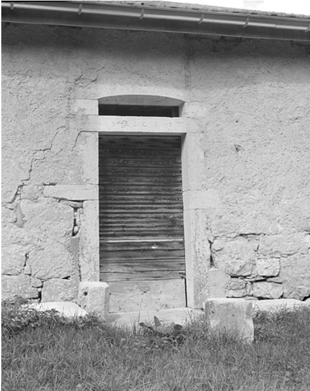
Porte du logis sur la façade antérieure.
