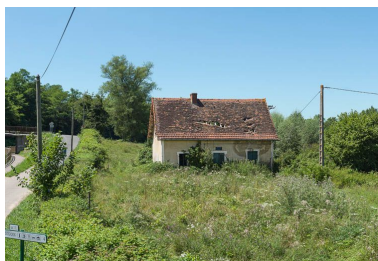
La maison de face. Phot. Pierre-Marie Barbe-Richaud IVR26_20137100534NUC4AQ
