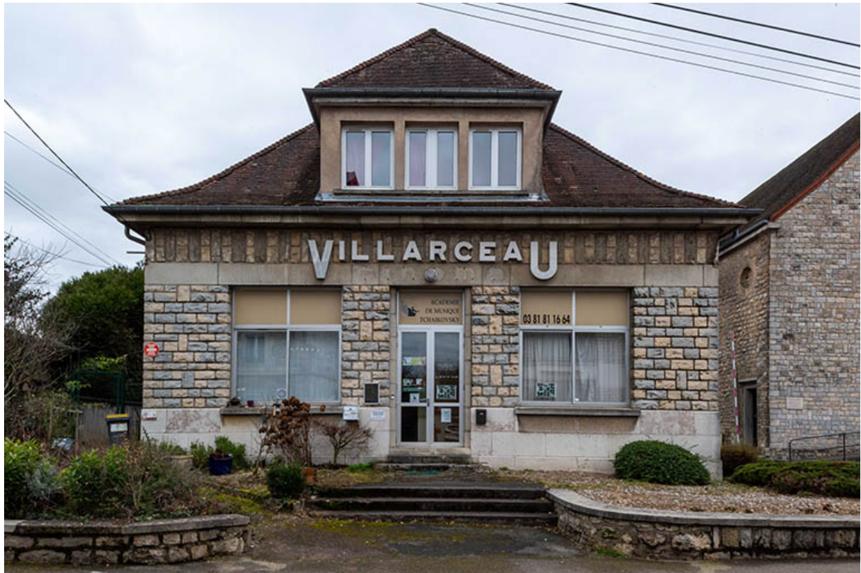
Façade nord de la maison des œuvres - Cinéma Villarceau.
