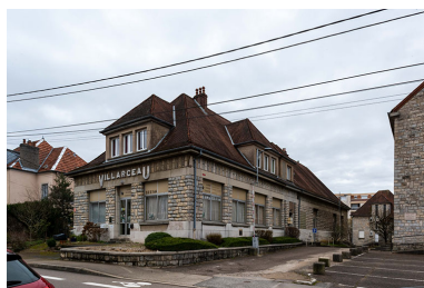
Façades nord et ouest de la maison des œuvres - Cinéma Villarceau, de trois-quarts. Phot. Aline Thomas IVR43_20222500085NUC4A
