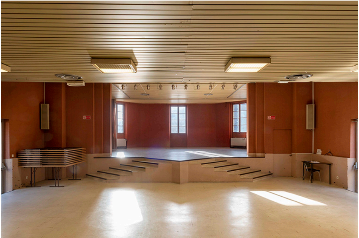
Vue intérieure de l'ancienne salle de cinéma, depuis la cloison mobile en direction de la scène.
