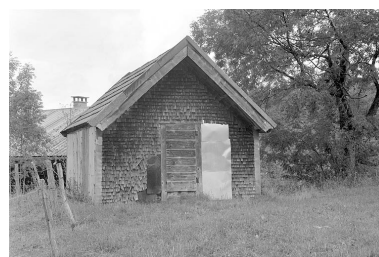
Le grenier fort. Phot. Jérôme Mongreville IVR43_19963901346X
