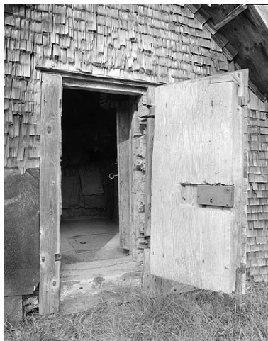
Les deux portes du grenier fort ouvertes. Phot. Jérôme Mongreville IVR43_19963901343X
