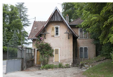
Façade sud de la conciergerie. Phot. Jérôme Mongreville IVR43_20112501558NUC4A
