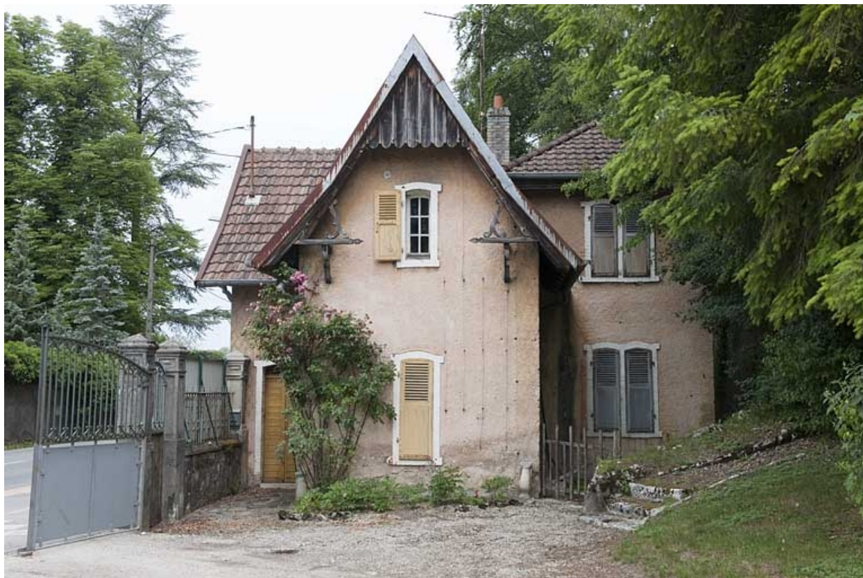
Façade sud de la conciergerie.
