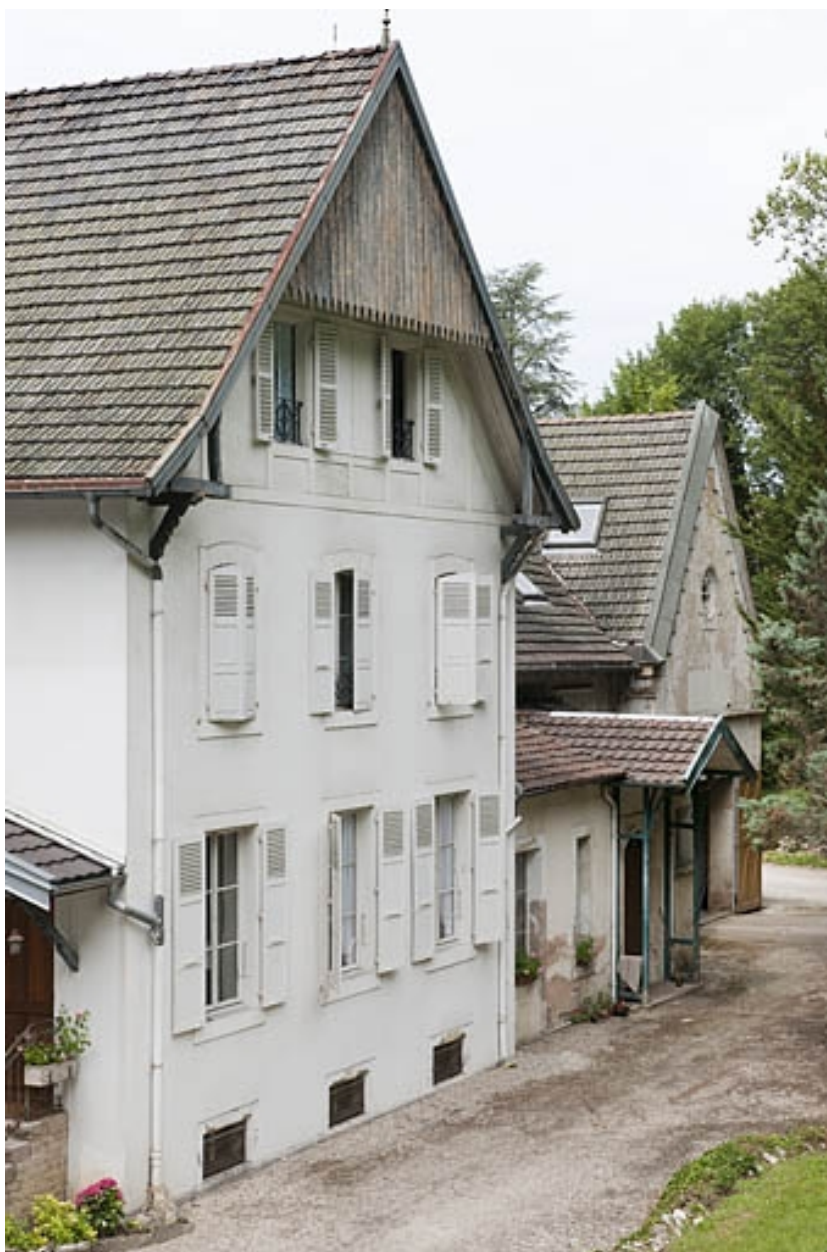
Détail des pignons de la façade postérieure.
