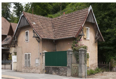
La conciergerie vue de trois quarts. Phot. Jérôme Mongreville IVR43_20112501565NUC4A
