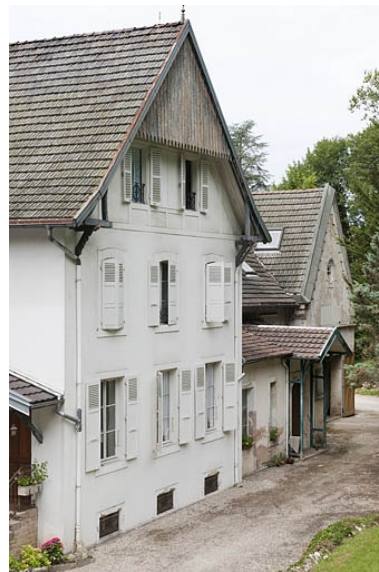
Détail des pignons de la façade postérieure. Phot. Jérôme Mongreville IVR43_20112501562NUC4A
