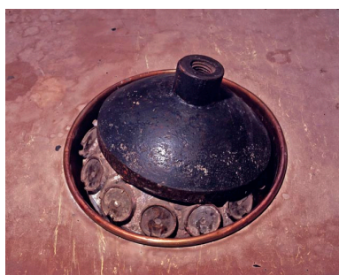
La "balle" et le "bassin". IVR43_20033901017XA
