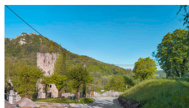
Vue d'ensemble depuis l'est. Phot. Thierry Kuntz IVR43_20223900604NUC4A
