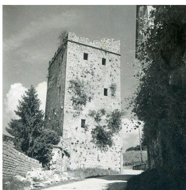
Vue depuis la rue de Chambenoiz, milieu 20e siècle. Phot. Georges Chenu IVR43_20243900116NUC4A
