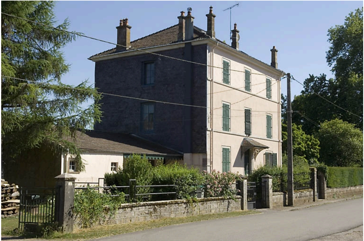
Logement patronal sud. Vue de trois quarts.
