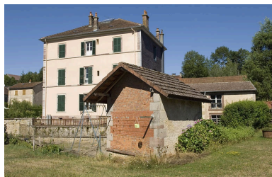
Logement patronal sud. Façade postérieure. Phot. Jérôme Mongreville IVR43_20067000592NUCA
