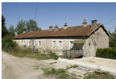
Logement ouvrier collectif (impasse Albert Ricot). Phot. Jérôme Mongreville IVR43_20067000620NUCA
