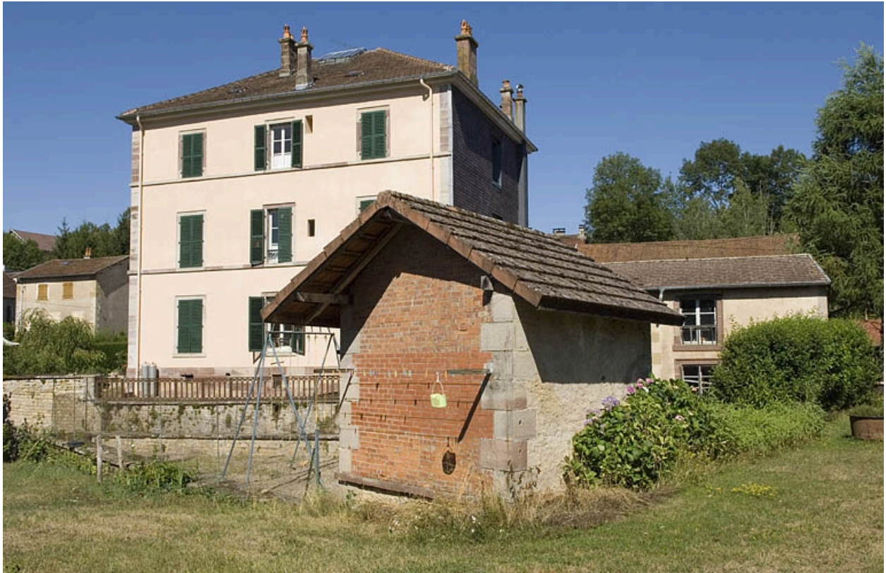
Logement patronal sud. Façade postérieure.
