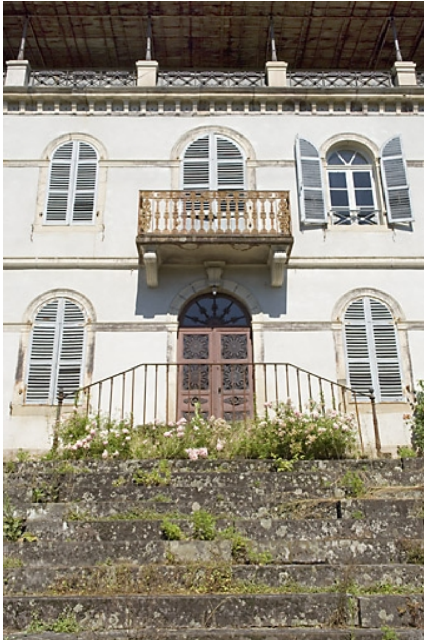
Logement patronal nord. Détail des travées centrales.
