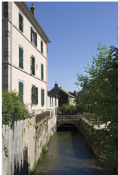
Bief de dérivation aval du Planey. Phot. Jérôme Mongreville IVR43_20067000608NUCA
