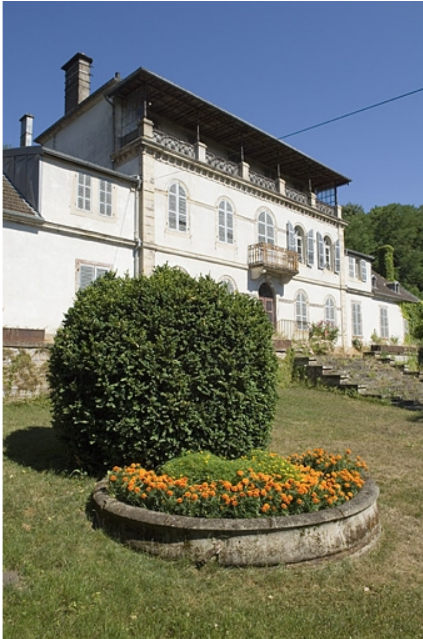
Logement patronal nord. Vue de trois quarts.
