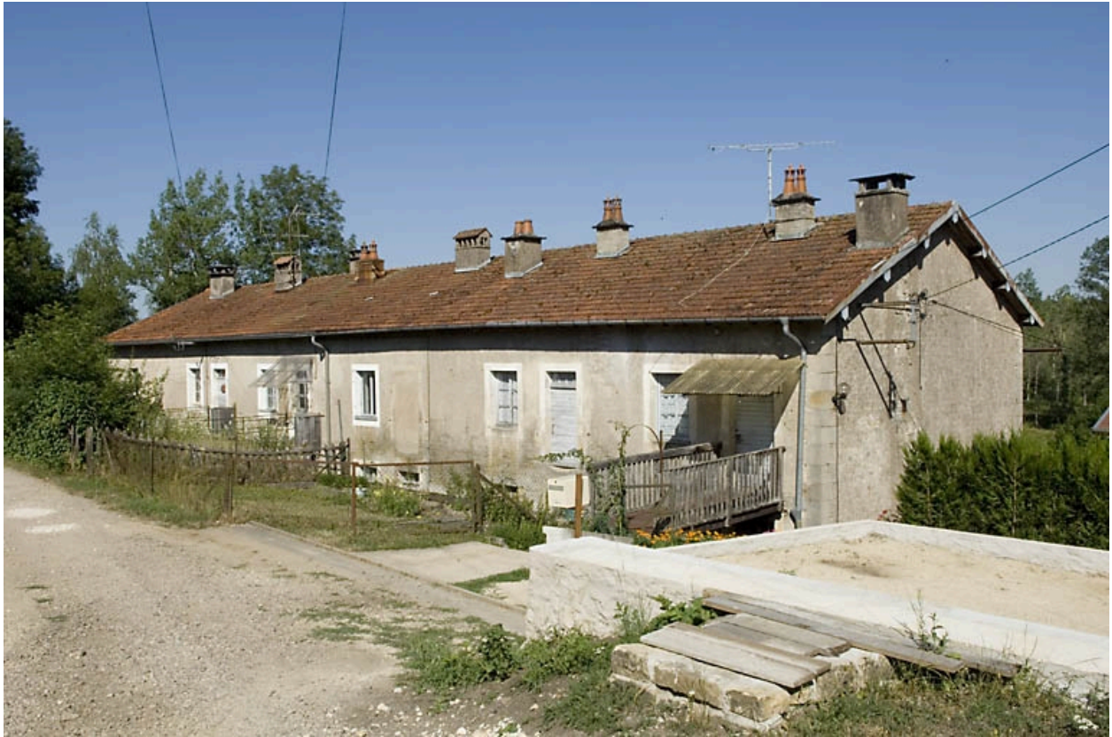
Logement ouvrier collectif (impasse Albert Ricot).
