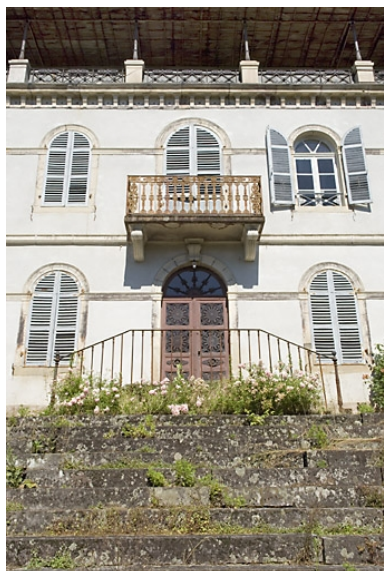
Logement patronal nord. Détail des travées centrales. Phot. Jérôme Mongreville IVR43_20067000601NUCA
