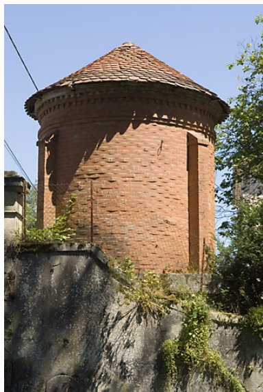
Château d'eau à usage domestique. Phot. Jérôme Mongreville IVR43_20067000611NUCA
