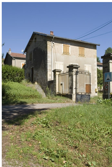
Logement d'ouvriers à l'entrée. Phot. Jérôme Mongreville IVR43_20067000607NUCA
