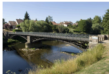
Pont métallique sur la Lanterne (commune de Bourguignon- lès-Conflans). Réalisation des forges de Varigney. Phot. Jérôme Mongreville IVR43_20067000621NUCA
