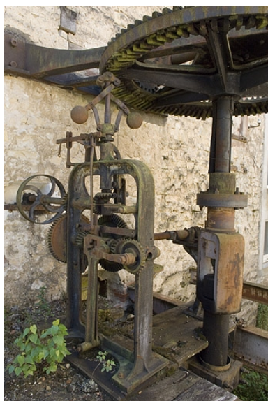
Partie supérieure de la turbine hydraulique. Régulateur à boules. Phot. Jérôme Mongreville IVR43_20067000606NUCA
