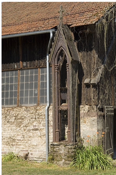
Pinacle en fonte adossé au magasin industriel. Phot. Jérôme Mongreville IVR43_20067000593NUCA
