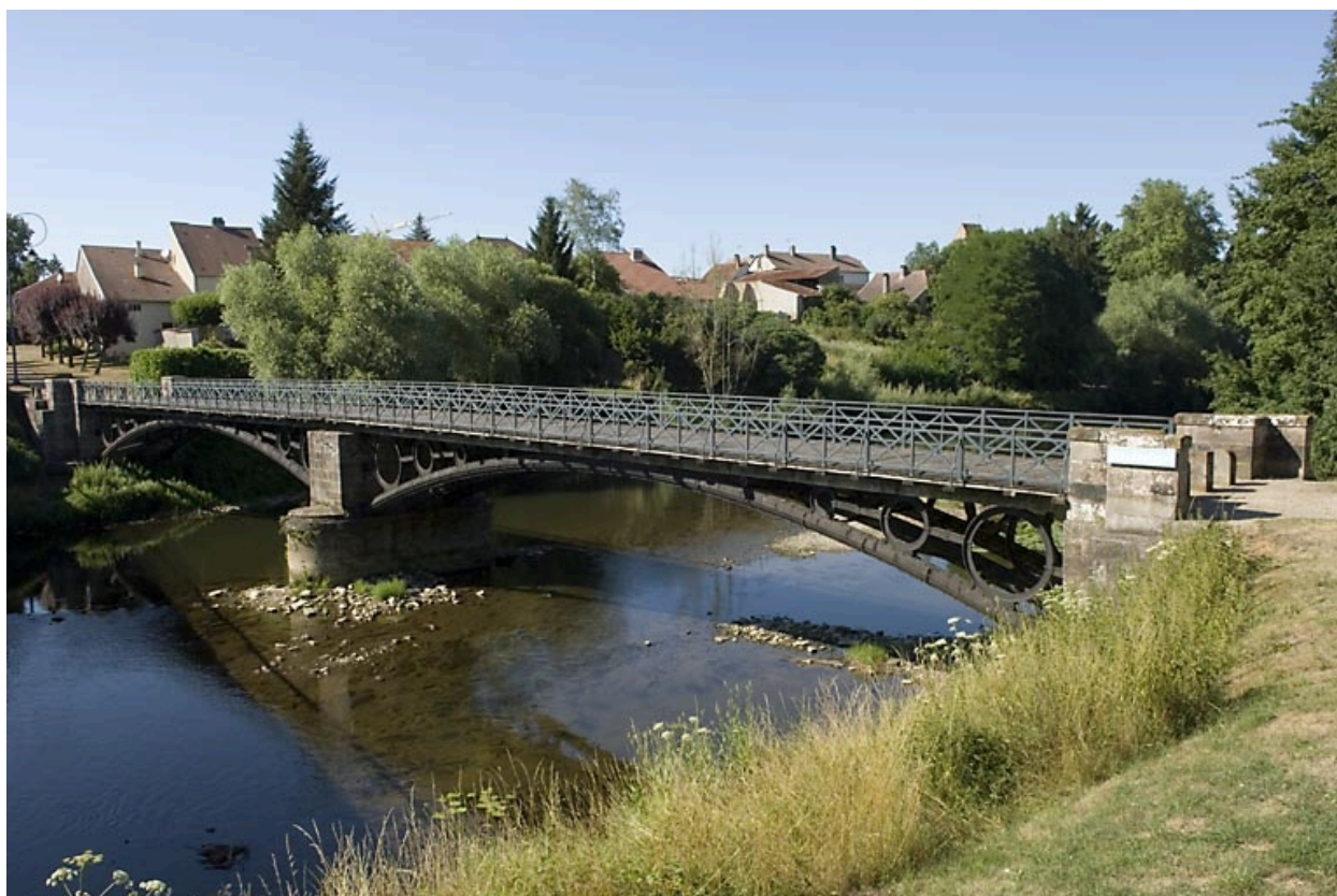
Pont métallique sur la Lanterne (commune de Bourguignon-lès-Conflans). Réalisation des forges de Varigney.
