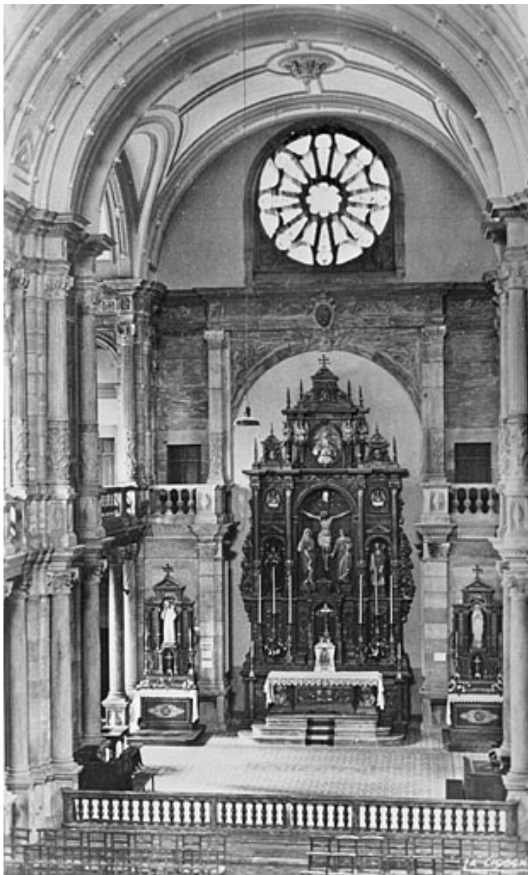
Vue intérieure du choeur de l'église, 1ère moitié 20e siècle.
