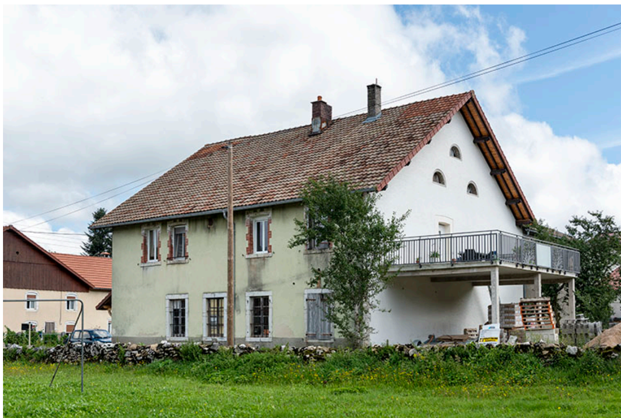
Façades postérieure et latérale droite.
