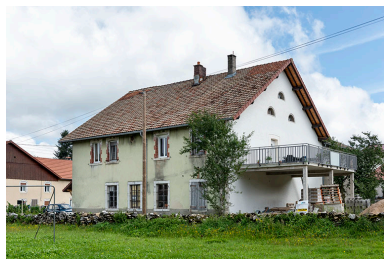
Façades postérieure et latérale droite.
