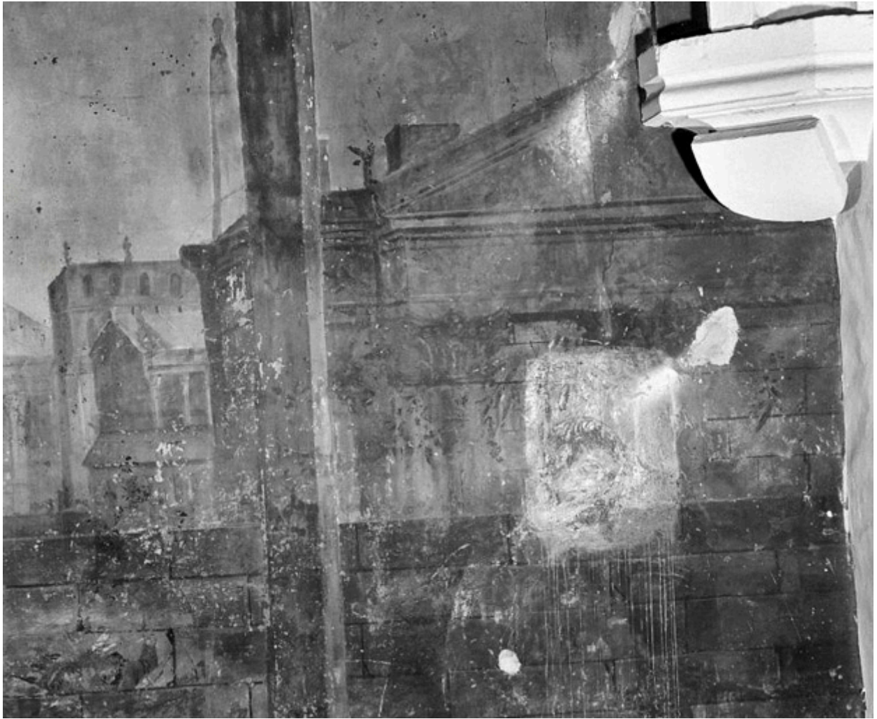
Partie supérieure (1991) : architecture à droite.
