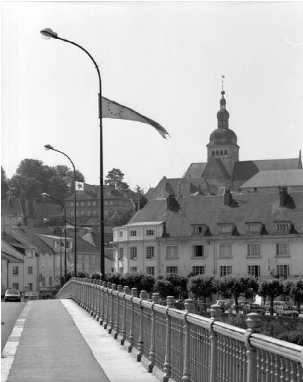
Vue du garde-corps en fonte.
