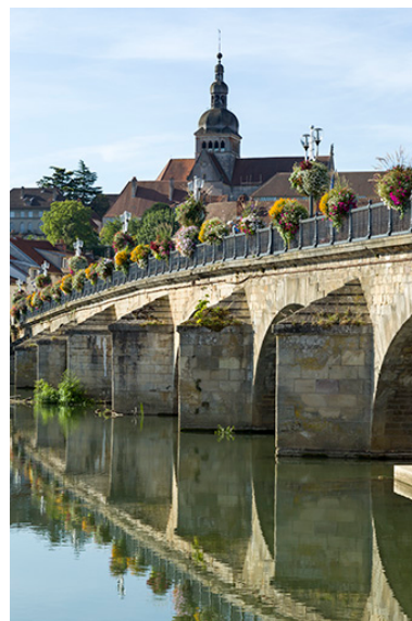
Détail des avant-bec des piles. Phot. Sonia Dourlot IVR43_20167001839NUC2A
