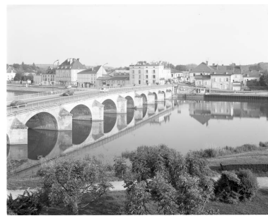
Vue d'ensemble depuis la ville basse. Phot. Yves Sancey IVR43_19897000490V
