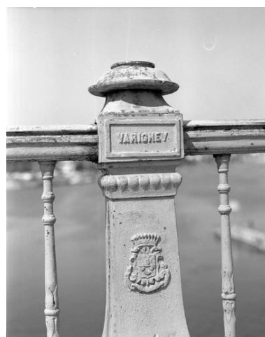
Détail du garde-corps : vue de l'inscription et du blason de la ville de Gray sur le balustre central.
