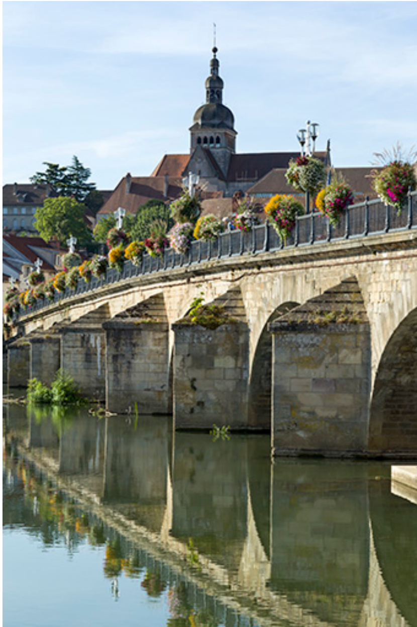
Détail des avant-bec des piles.
