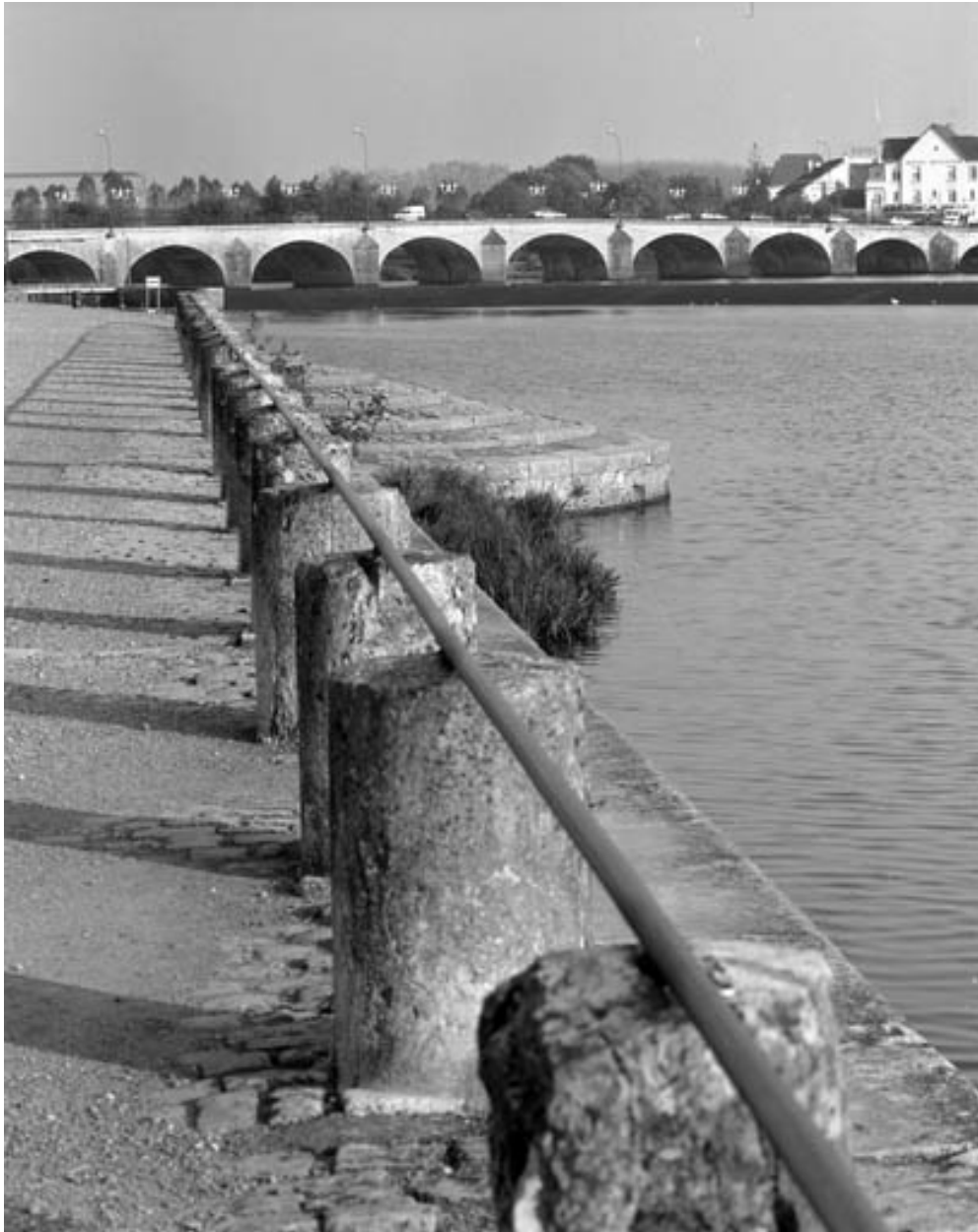
Vue d'ensemble depuis le quai de l'Ecluse.
