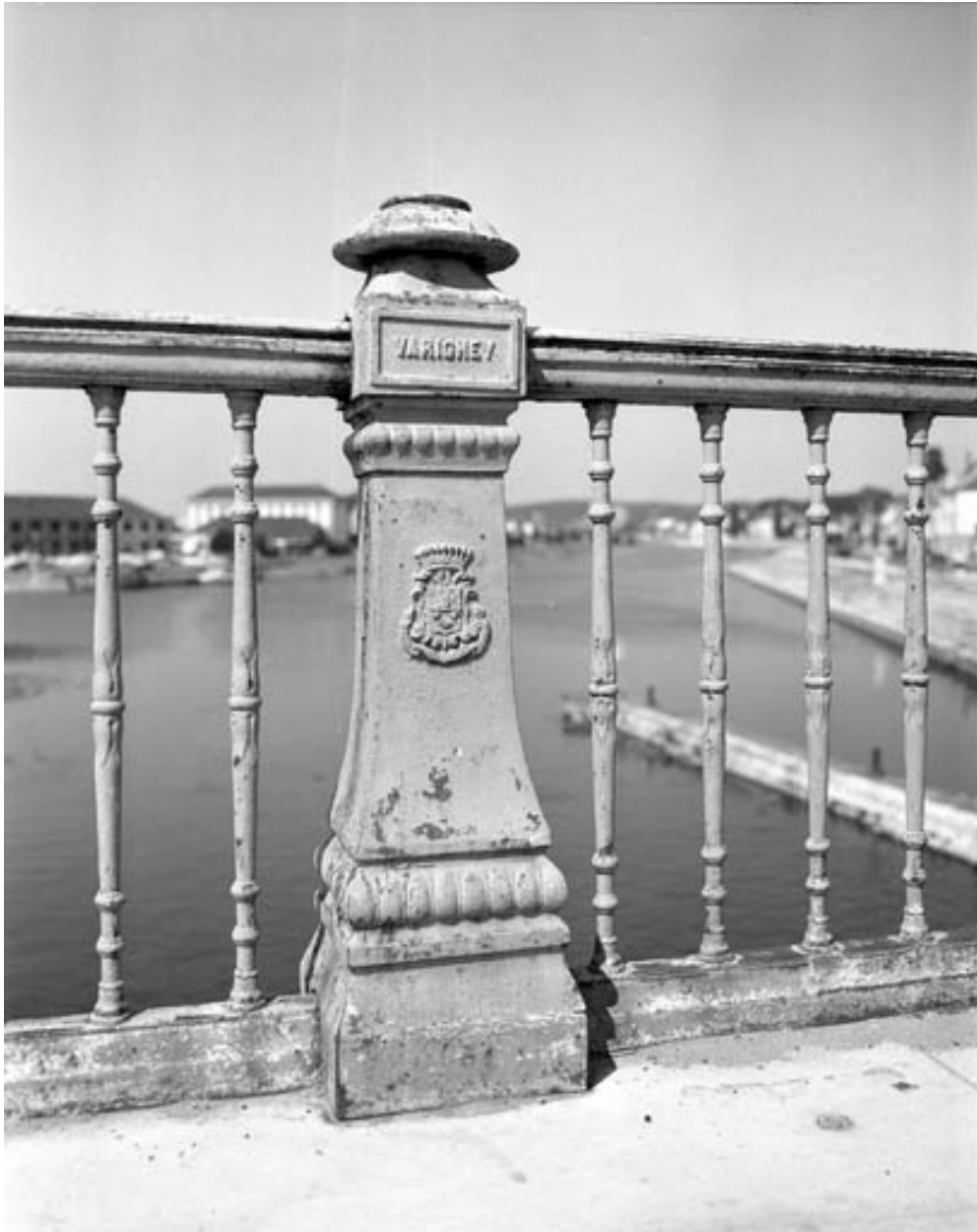
Détail du garde-corps : vue du balustre central.
