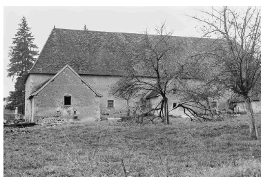
Vue postérieure de la grange au début des années 1970, avec les trois petits édifices ayant servi de soies à cochons, de réserve à betteraves et de remise à bois. L'édicule central a disparu suite à la construction d'une stabulation dans la seconde moitié des années 1970. Phot. Raymond Oursel IVR26_20207100079NUC2
