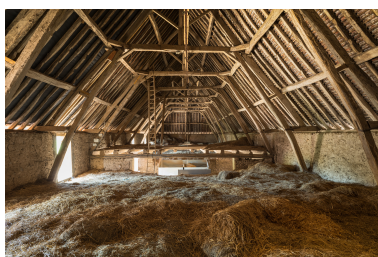
Charpente du bâtiment agricole. Vue depuis le fenil (cadrage horizontal). Phot. Pierre-Marie Barbe-Richaud IVR26_20187100132NUC4A
