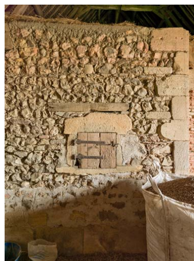
Ouverture (dite feuron) dans le mur de séparation entre l'étable et la remise. Phot. Pierre-Marie Barbe-Richaud IVR26_20187100032NUC4A
