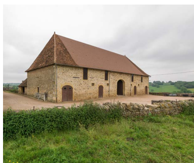
L'étable vue de trois quarts gauche. Phot. Pierre-Marie Barbe-Richaud IVR26_20187100030NUC4AQ
