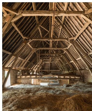
Charpente du bâtiment agricole. Vue depuis le fenil (cadrage vertical). Phot. Pierre-Marie Barbe-Richaud IVR26_20187100133NUC2A
