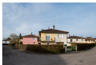
Lotissement, avenue du Plein Soleil. Phot. Jérôme Mongreville IVR43_20187000009NUC4A
