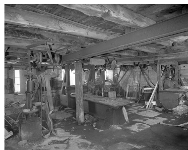
Intérieur de l'atelier de réparation. Phot. Yves Sancey IVR43_19943901353X
