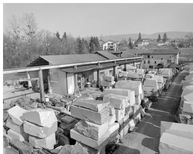
Vue d'ensemble des bâtiments depuis l'ouest. Phot. Yves Sancey IVR43_19943901348X
