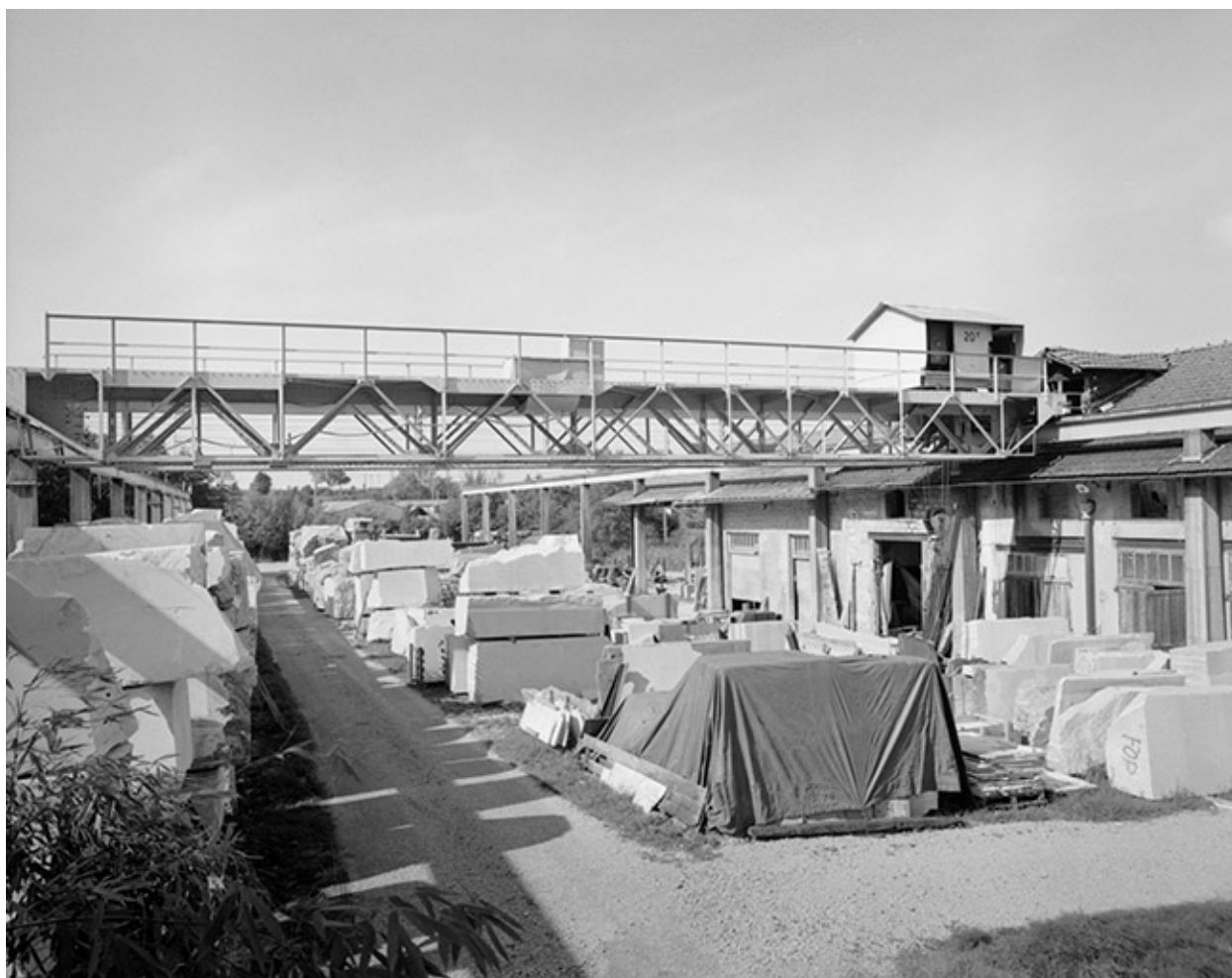
Atelier de fabrication et pont roulant.
