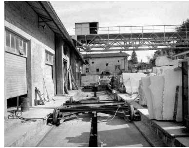
Chariot desservant l'atelier de fabrication. Phot. Yves Sancey IVR43_19933900155X
