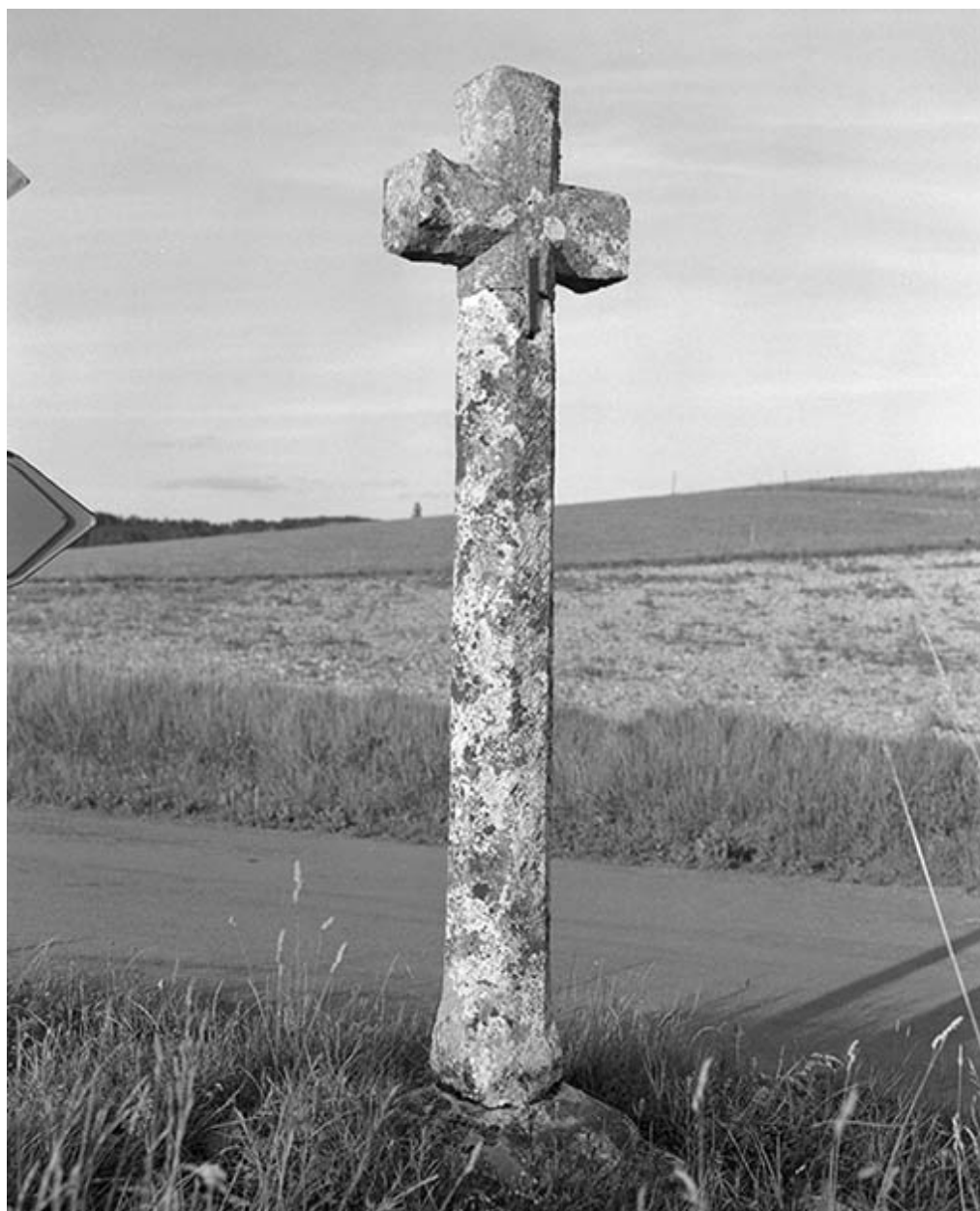
Croix de chemin, dite croix de Pierre.
