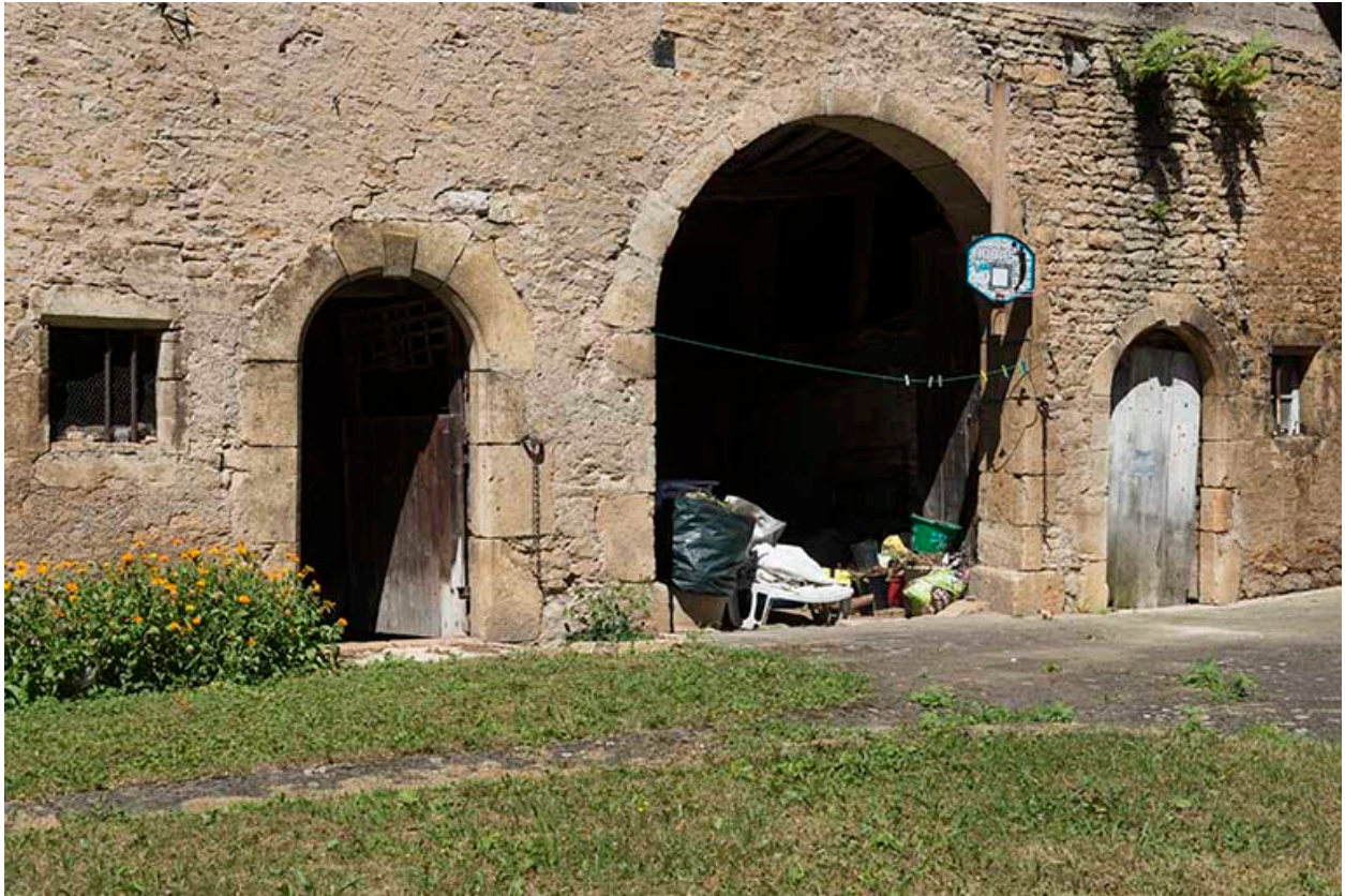
Portes de la remise.
