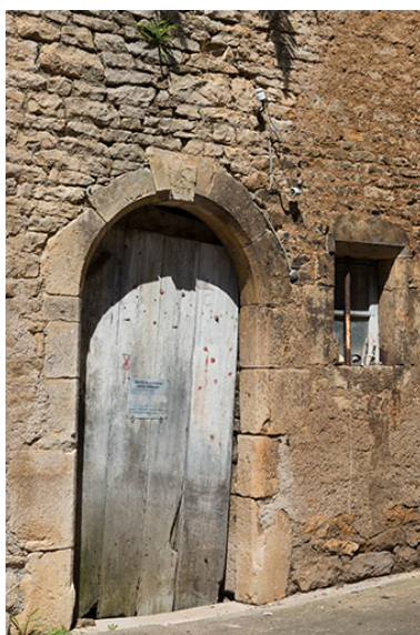
Porte de la remise.
